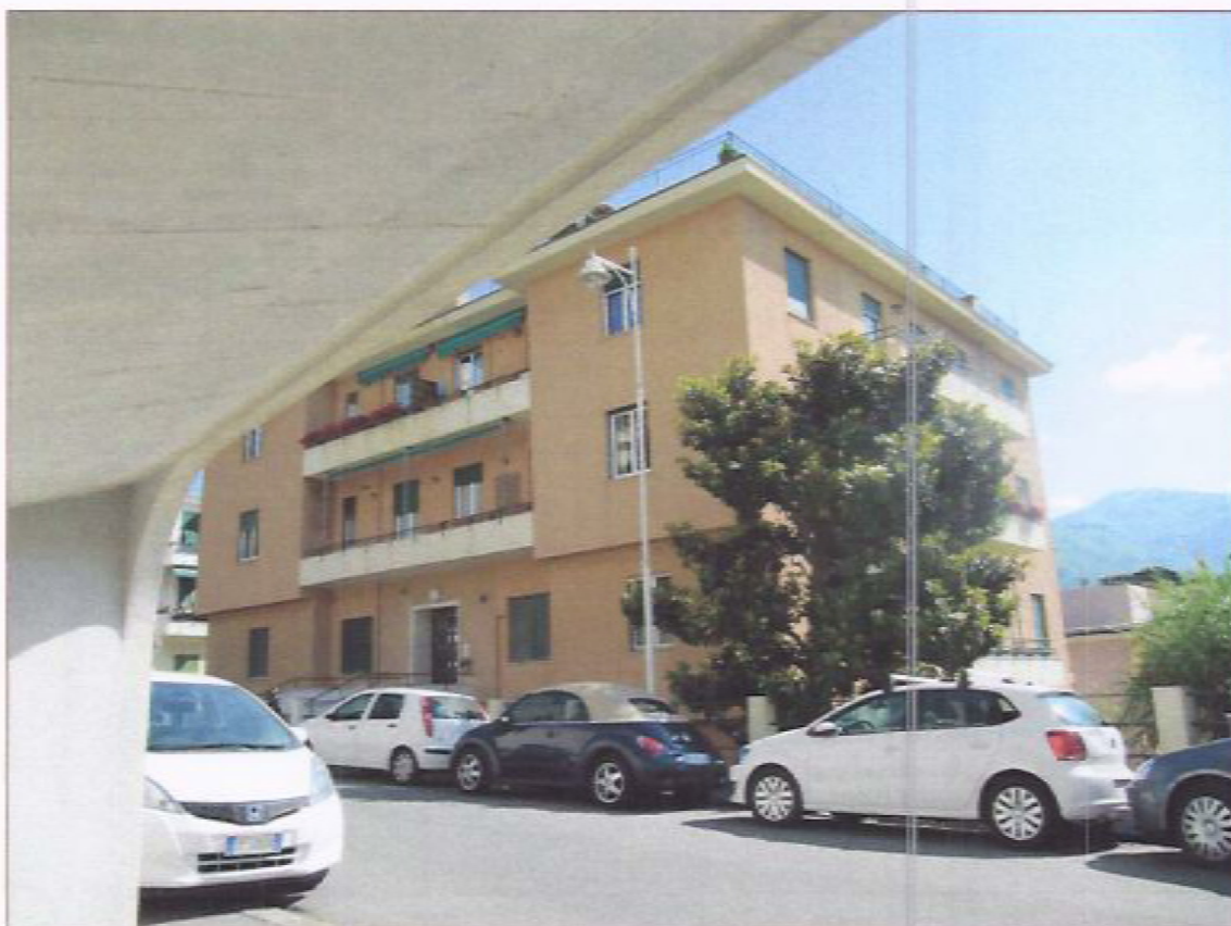
Vista del fabbricato da via Orlando
