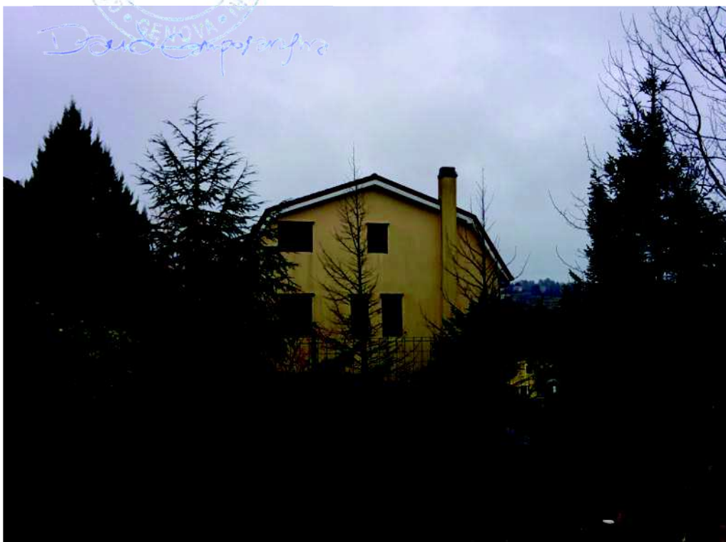
FOTO N°. 4: Prospetto Sud
