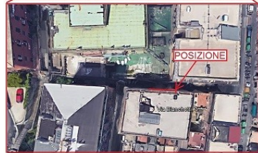
LA POSIZIONE DELL'IMMOBILE
