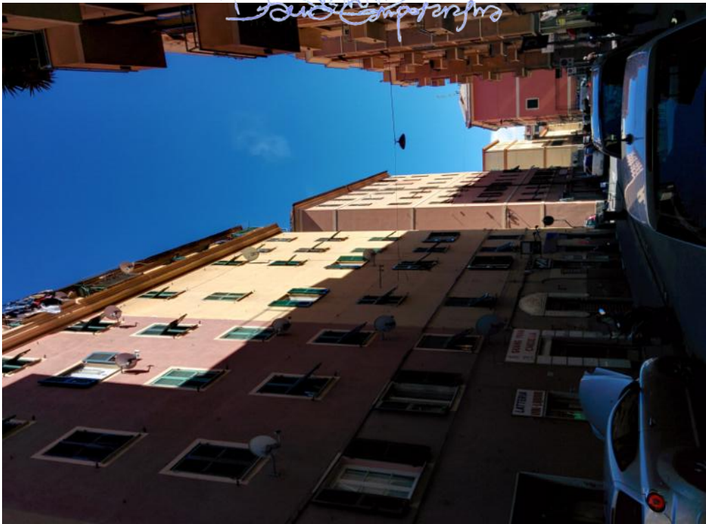
FOTO N°. 2: Via Carlo Rolando
