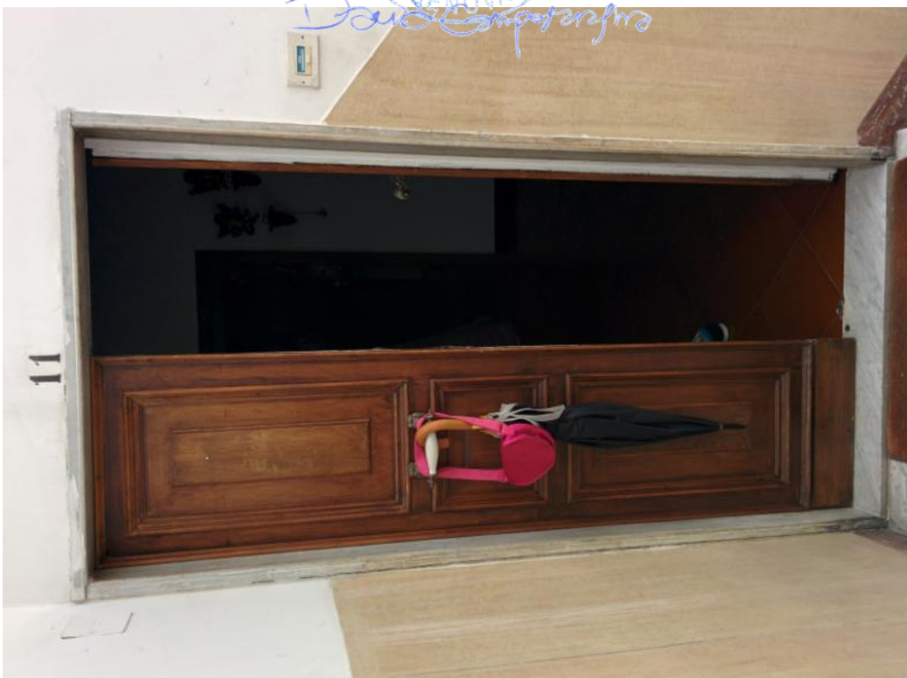
FOTO N°. 8: Porta d'ingresso Interno 11
