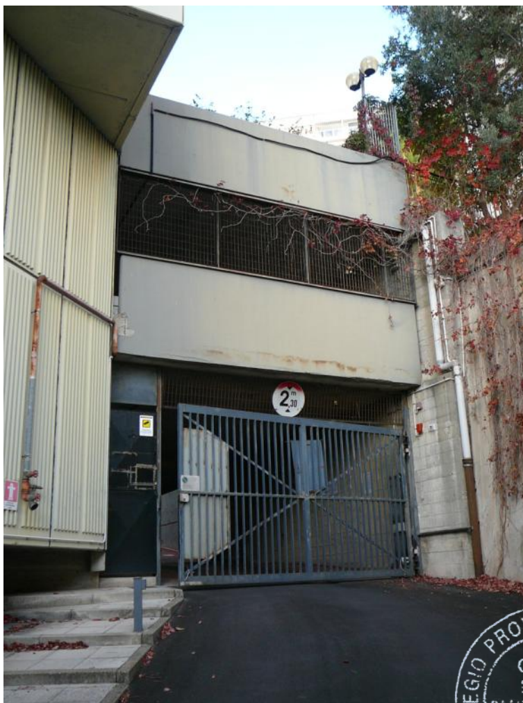
FOTO N°. 1: Ingresso Civ.71
