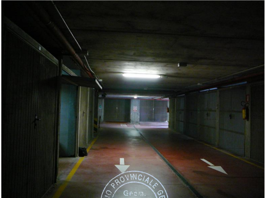
FOTO N°. 5: Area di manovra
