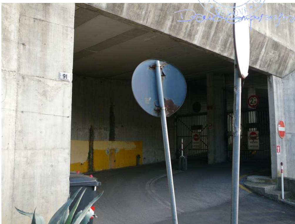
FOTO N°. 2: Ingresso Civ.91
