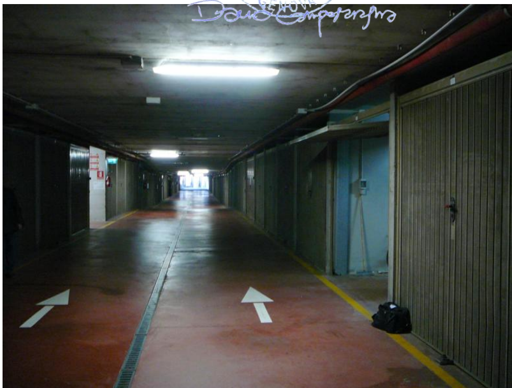
FOTO N° 4: Area di manovra
