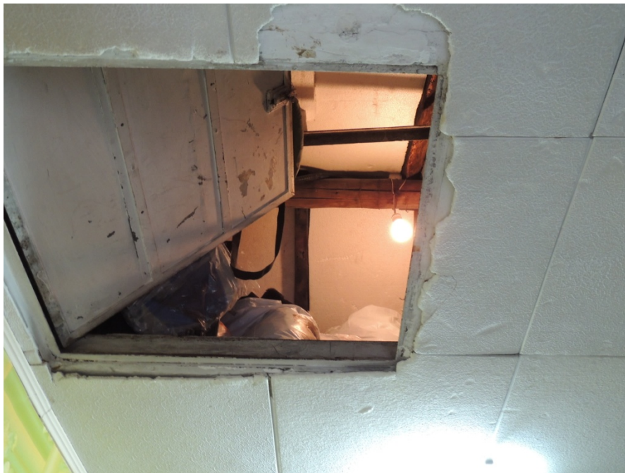
Foto n 13 Botola nel controsoffitto del bagno
