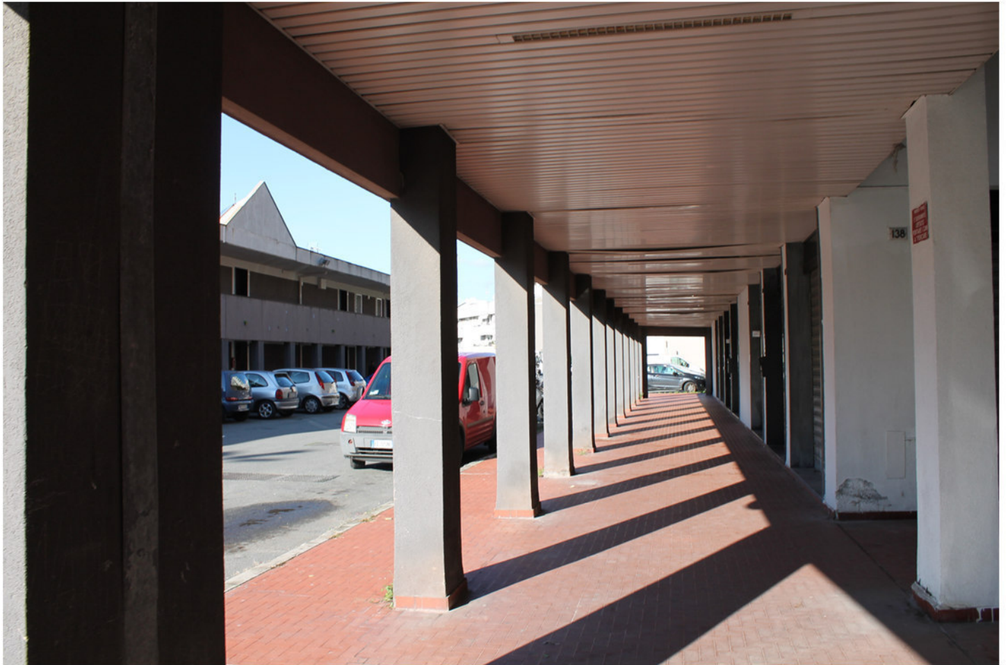
via delle Genziane: vista del porticato esterno antistante i civ. 164-166
