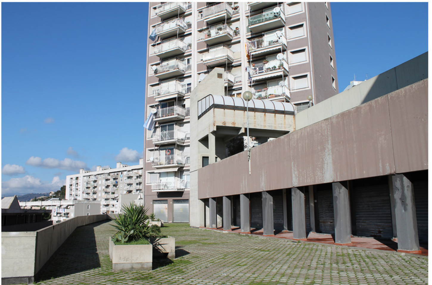
via delle Genziane: vista dello spazio esterno antistante i civ. 78-80, 82-84 e 86-88
