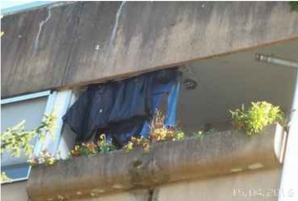
FOTO 4: PARTICOLARE DEL BALCONE LOGGIATO CON AFFACCIO SUL PROSPETTO NORD
