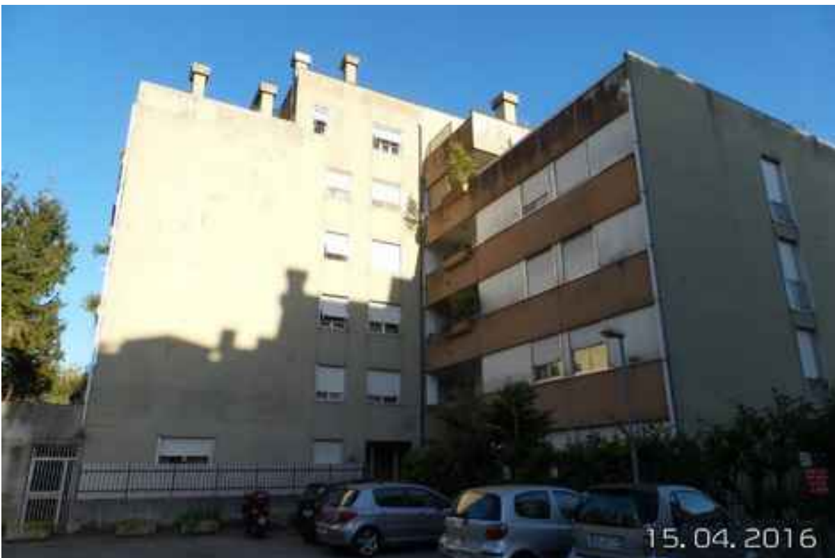
FOTO 2: VISTA DAL PIAZZALE SUL PROSPETTO OVEST OVE È COLLOCATO IL PORTONE
