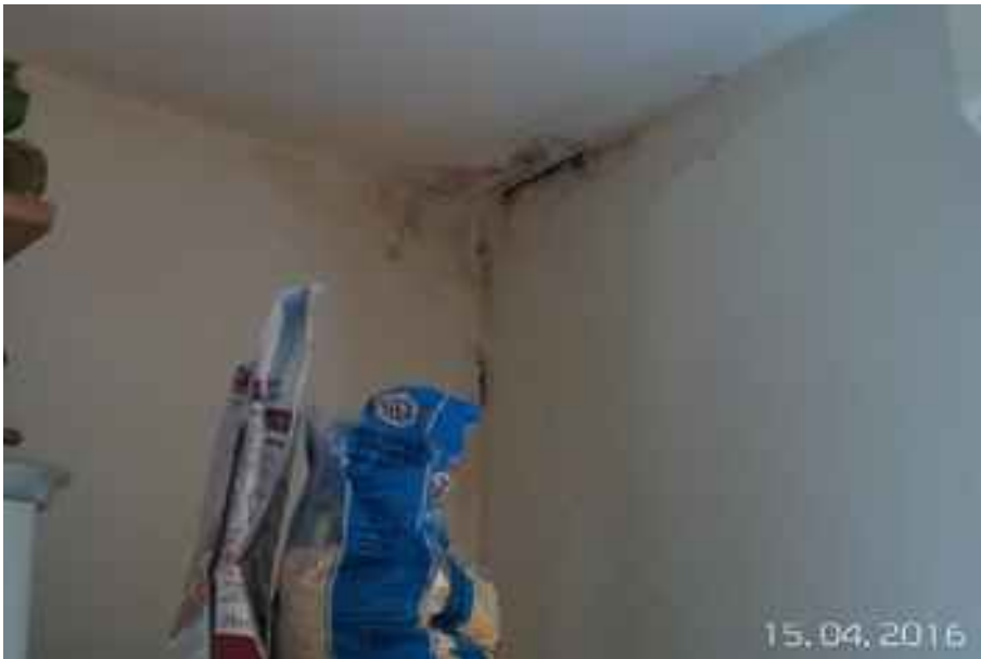
FOTO 25: CUCINA – PARTICOLARE DELLA MACCHIA DA INFILTRAZIONI
