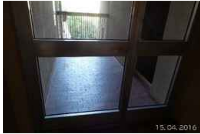
FOTO 5: VANO SCALA CON BALLATOIO IN ESTERNO; FOTO 6: PORTA DI ACCESSO AL CORRIDOIO INTERNO; FOTO 7: CORRIDOIO INTERNO;
