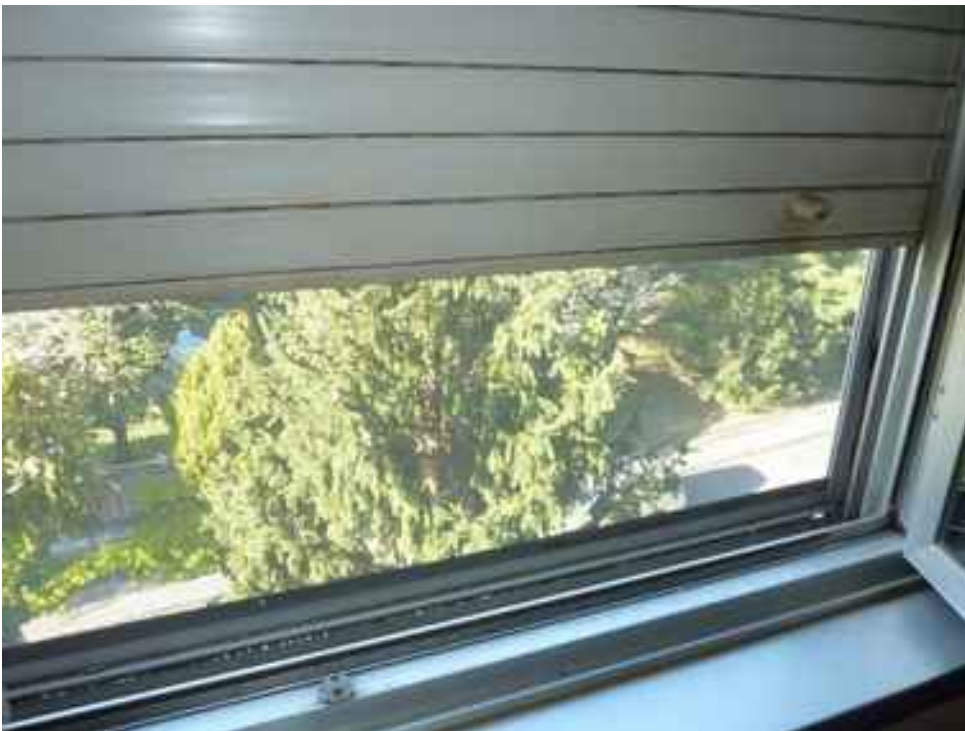
FOTO 18: PARTICOLARE DEI SERRAMENTI ESTERNI
