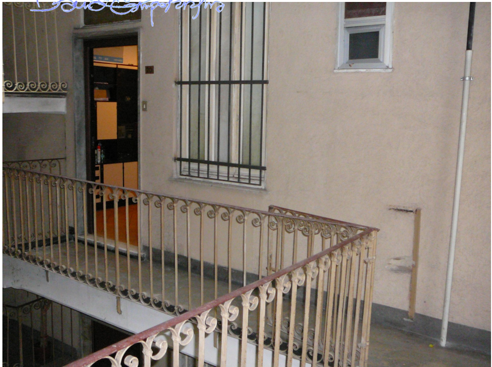
FOTO N°. 8: Ingresso dal corridoio condominiale
