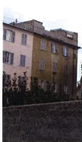
facciata a Ovest
