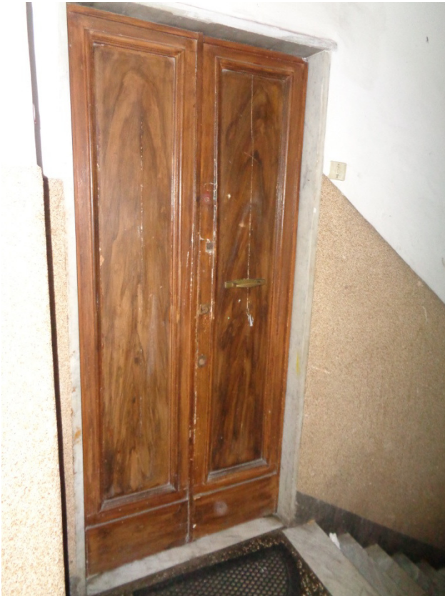
Foto 4: Porta di accesso
