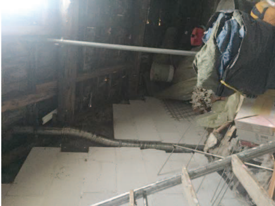
sottotetto-deposito compreso nell'appartamento
