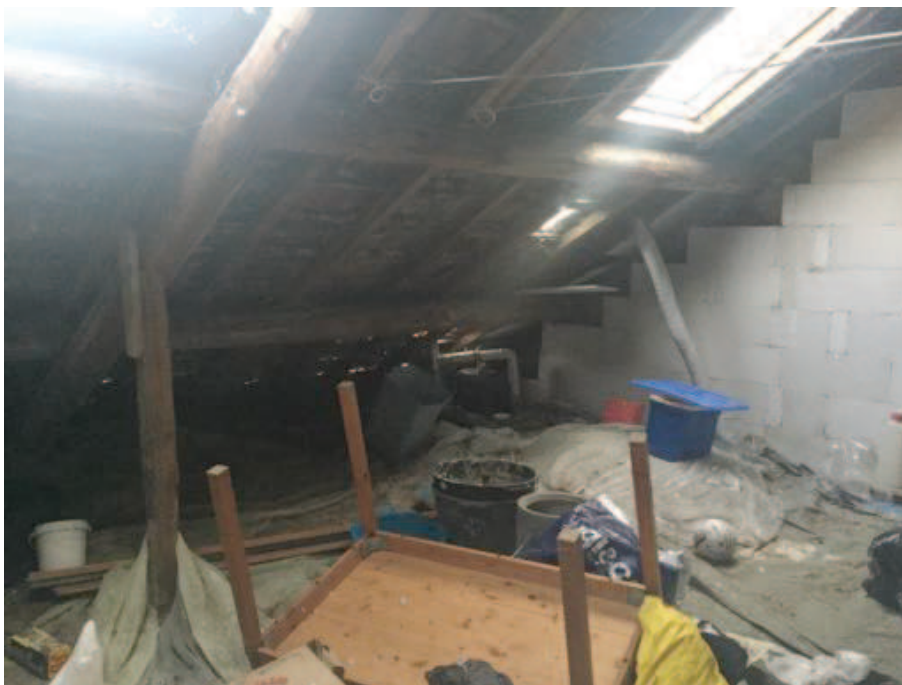
sottotetto-deposito compreso nell'appartamento
