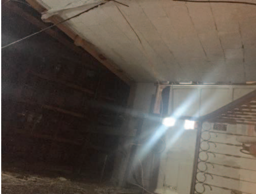
accesso al sottotetto dal vano scale condominiale
