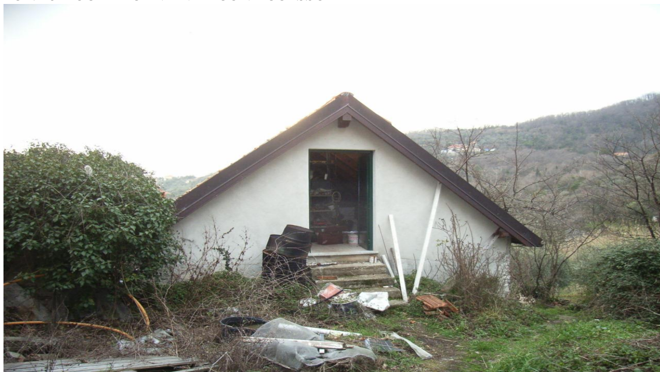
FOT. 18 LOCALE CANTINA – CON ACCESSO AL 1P
