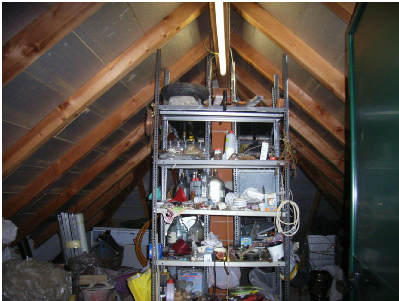
FOT. 19 INTERNO LOCALE CANTINA – 1P
