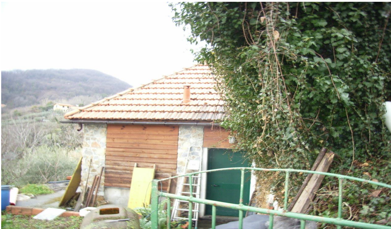
FOTO 4 – 5 MANUFATTO ADIBITO A CANTINA CON ACCESSO AL P.T
