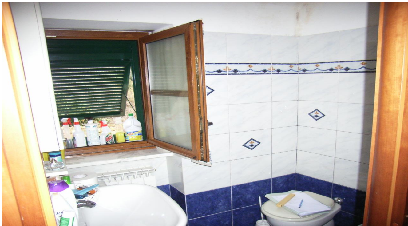
FOT. 17 LOCALE BAGNO – 2P
