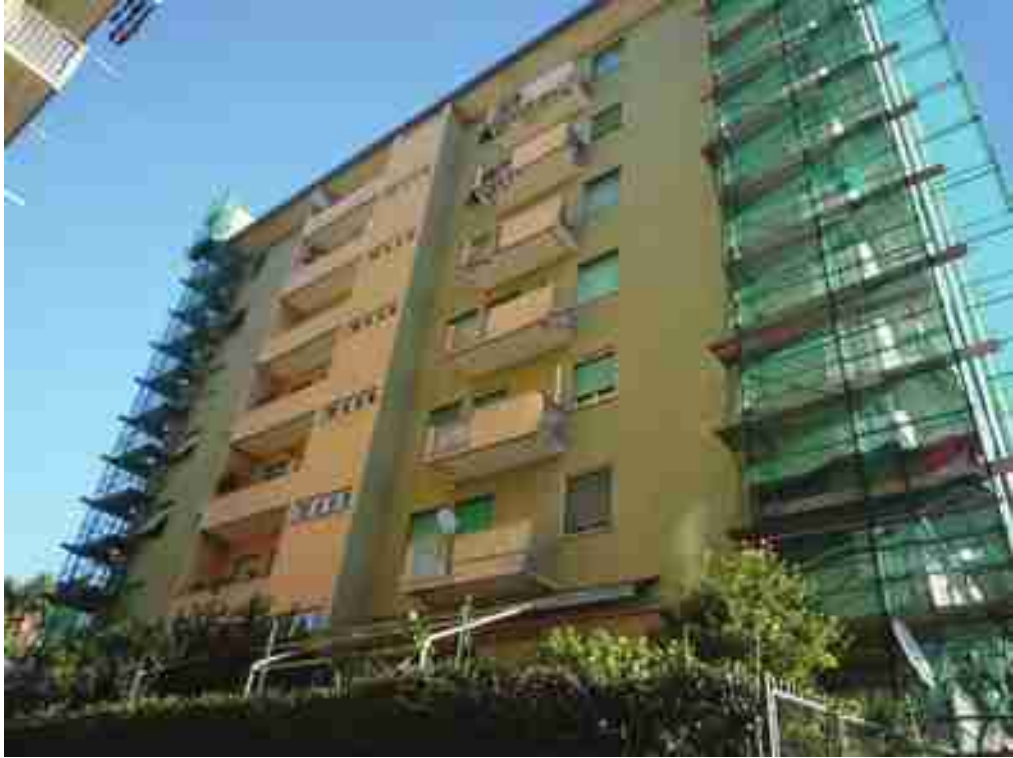
Prospetto Ovest - Fotografia 1
