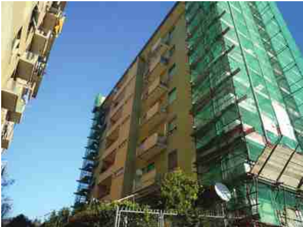
Prospetto Ovest e vista prospetto Sud con ponteggi - Fotografia 2
