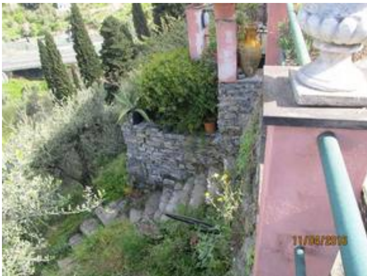
Fot. 8 - accesso al terreno agricolo
