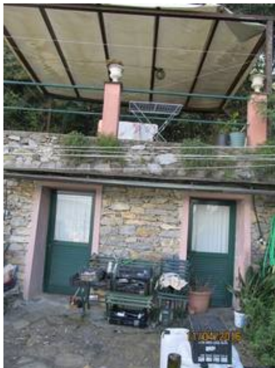
Fot. 6 - berceau sopra il magazzino
