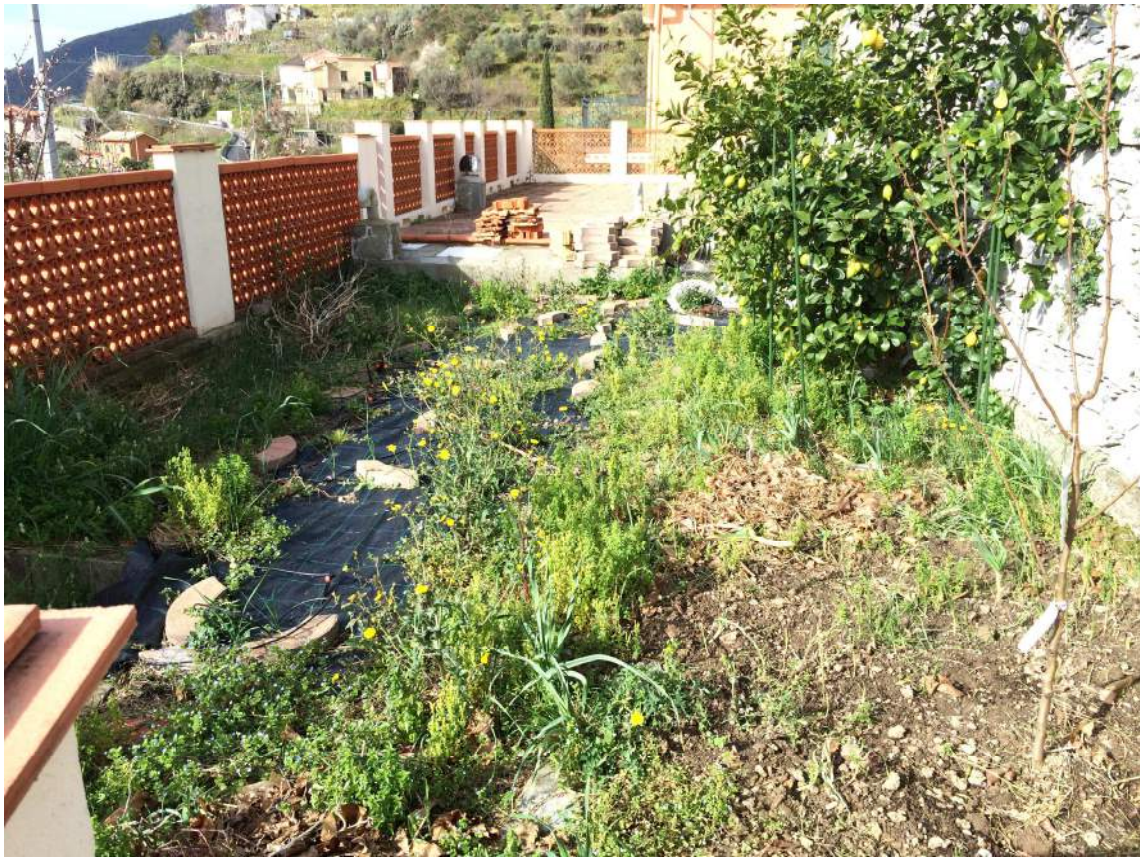
Vista della terrazza di copertura del volume ex-autorimessa (in secondo piano) e dell'adiacente terrapieno (in primo piano).
