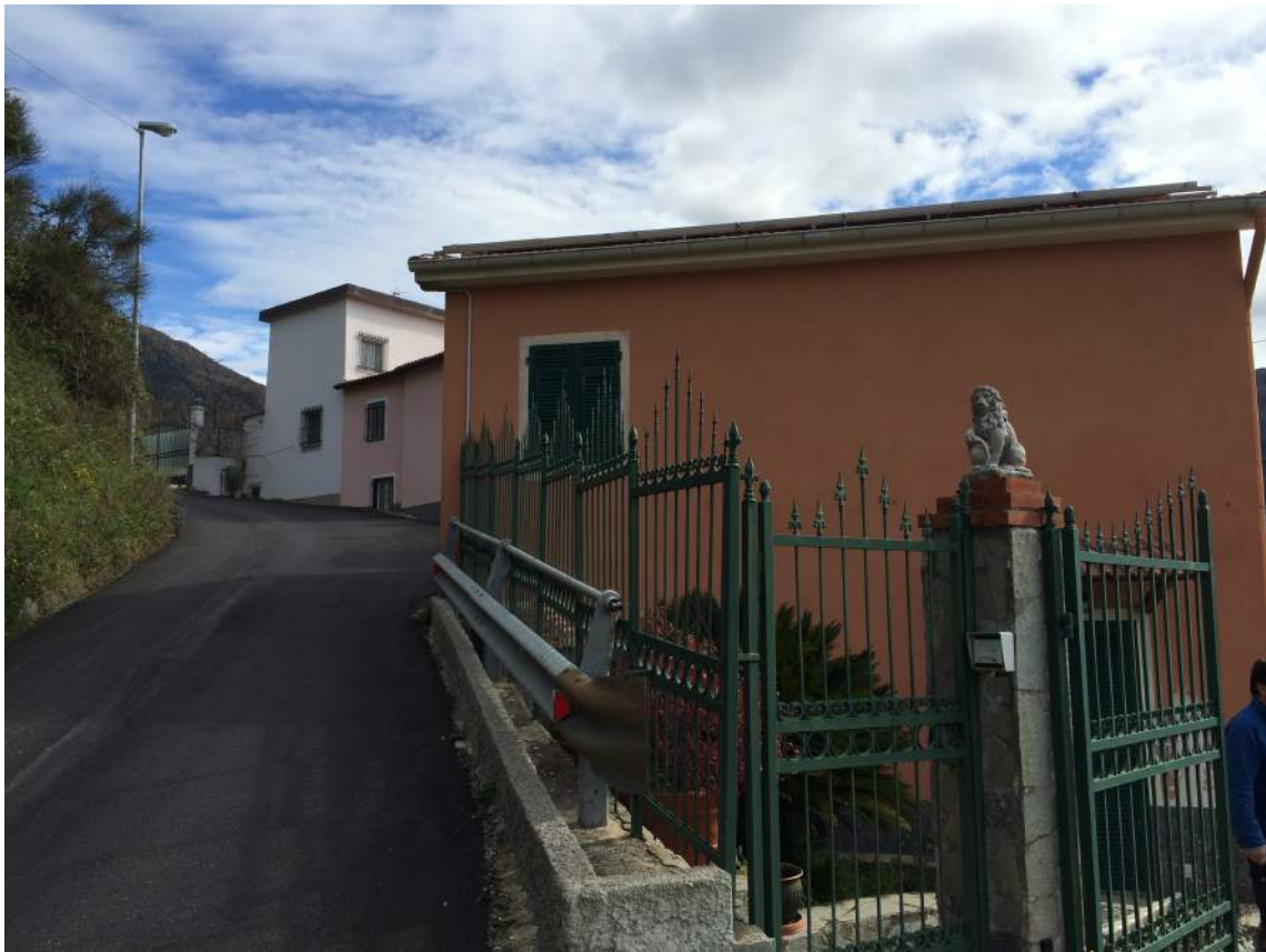
Vista del corpo originario in rapporto alla strada provinciale.
