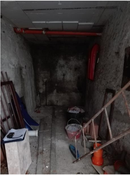
Piano terra, vista della cantina
