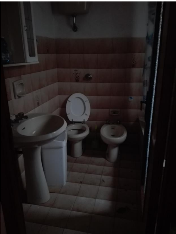
Piano primo, vista del bagno
