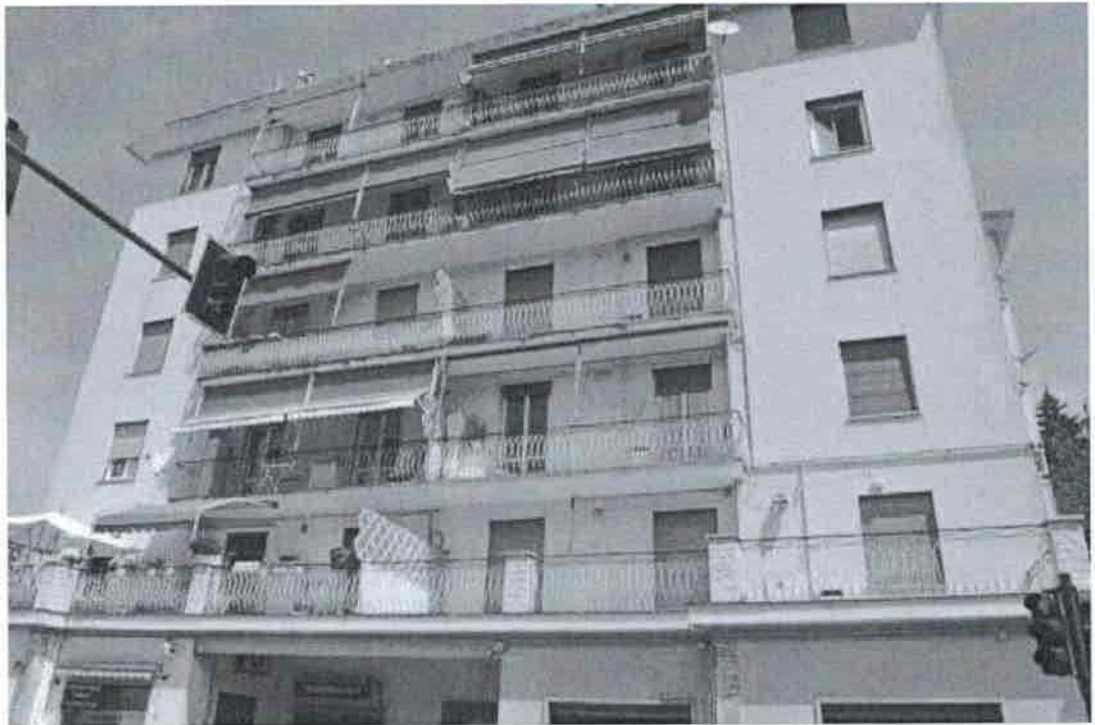
FOTO 10—prospetto principale civ. 201
