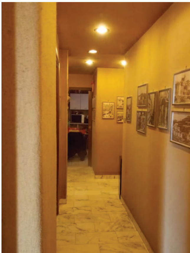
Particolare della pavimentazione in quadrotti di marmo del locale corridoio
