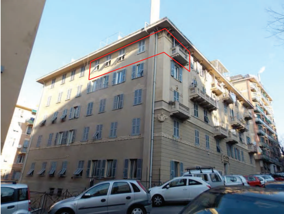
Veduta dell'edificio civ.6 dalla via Marsano verso SE ed individuazione del bene pignorato
