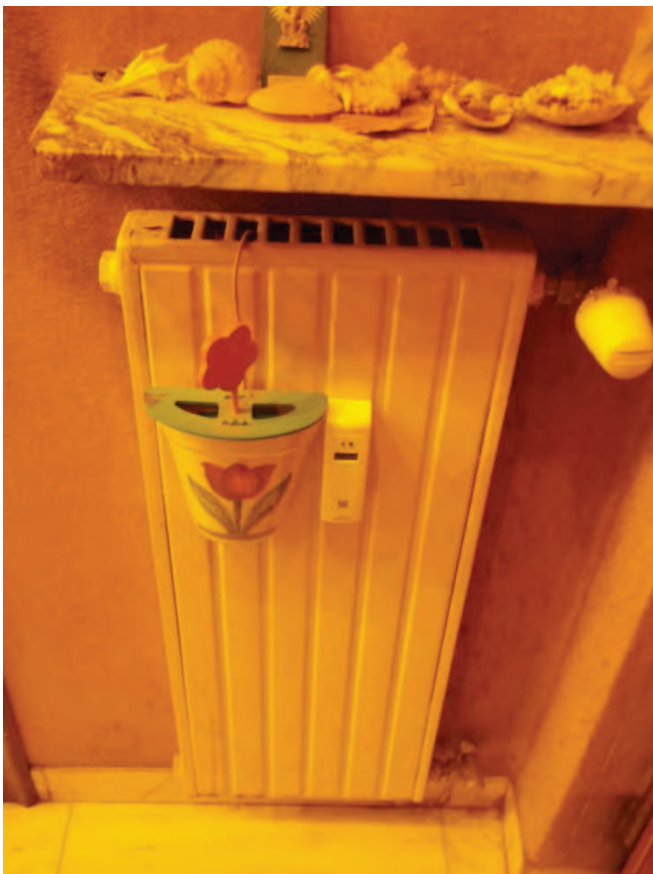
Particolare di piastra radiante dotata di valvola termostatica e contabilizzatore di calore
