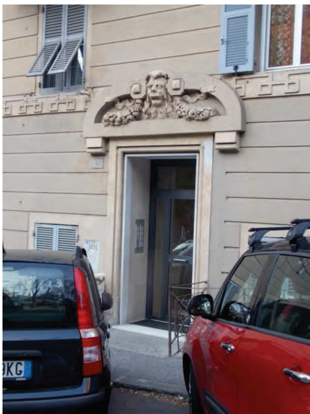
Veduta del portone d'accesso all'edificio dalla via Marsano
