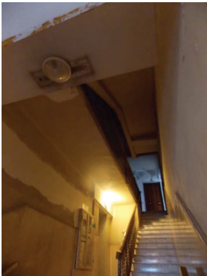
Vista del vano scala
