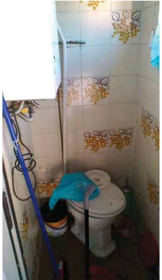
FOTO 6—WC ESTERNO NELLA VERANDA
