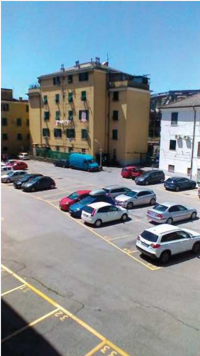
FOTO 25—VISUALE OVEST SUL CORTILE SOTTOSTANTE
