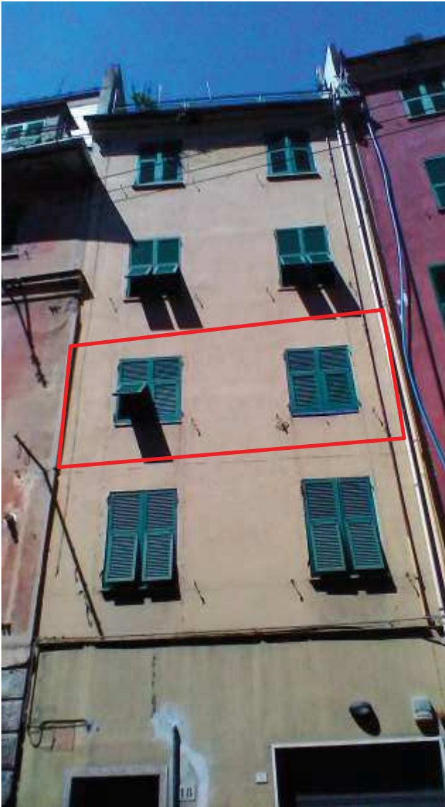
FOTO 3—PROSPETTO SU VIA CELESIA
