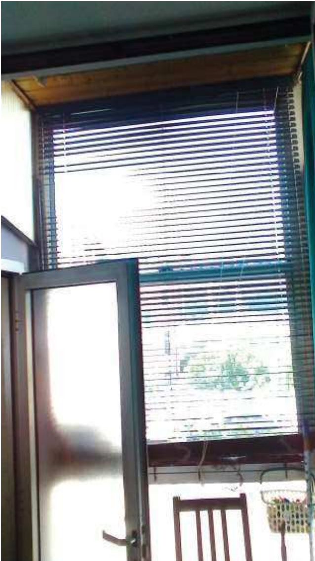
FOTO 7—VERANDA METALLICA E ACCESSO AL WC
