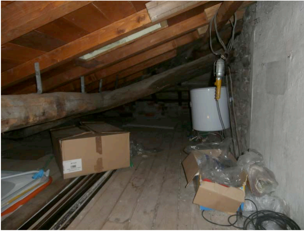
FOTOGRAFIA N° 13 COMMENTI: Vista del sottotetto.
