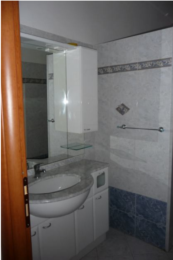
Foto 16. Bagno adiacente vano scala 6 A
