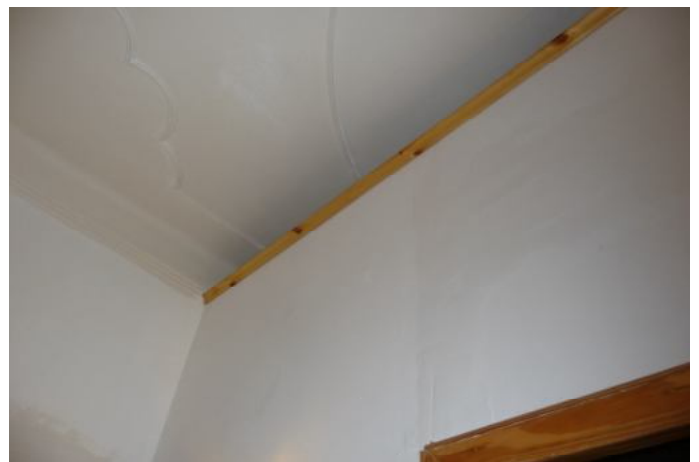
Foto 14. tramezza camera di fronte all'ingresso 6 A
