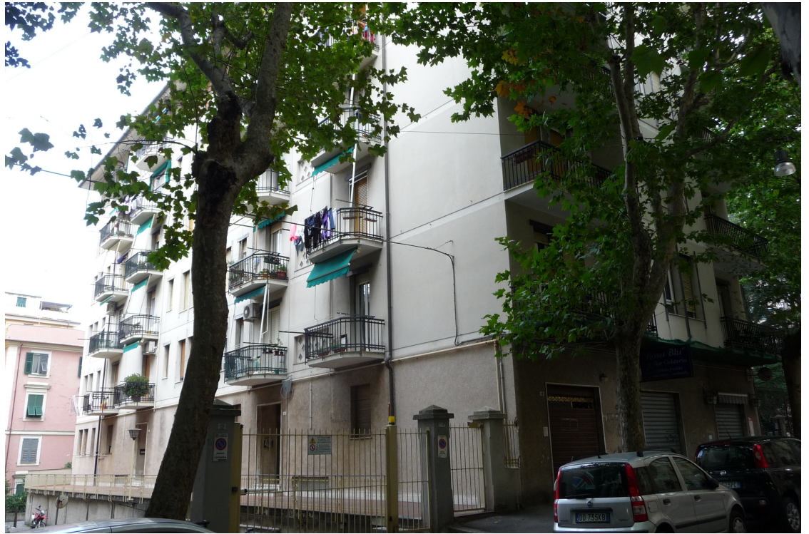
Foto 1. Il condominio civ. 6 A e 6 B dalla Via L. Ariosto.
