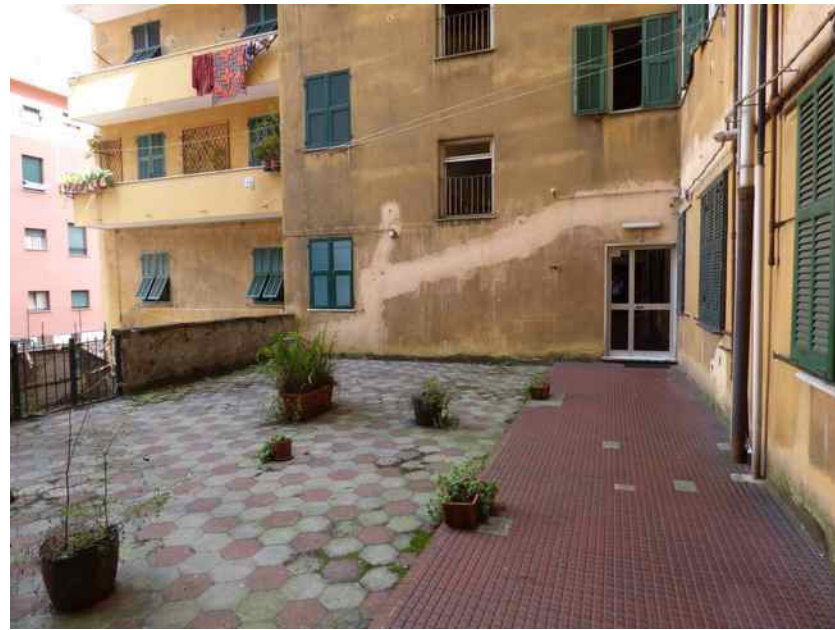
CORTILE ACCESSO SCALA B
