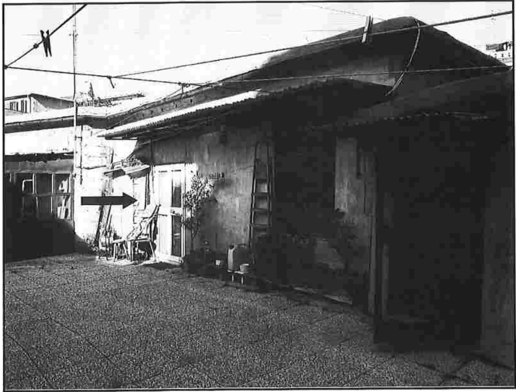
Foto 3 – accesso all' immobile
