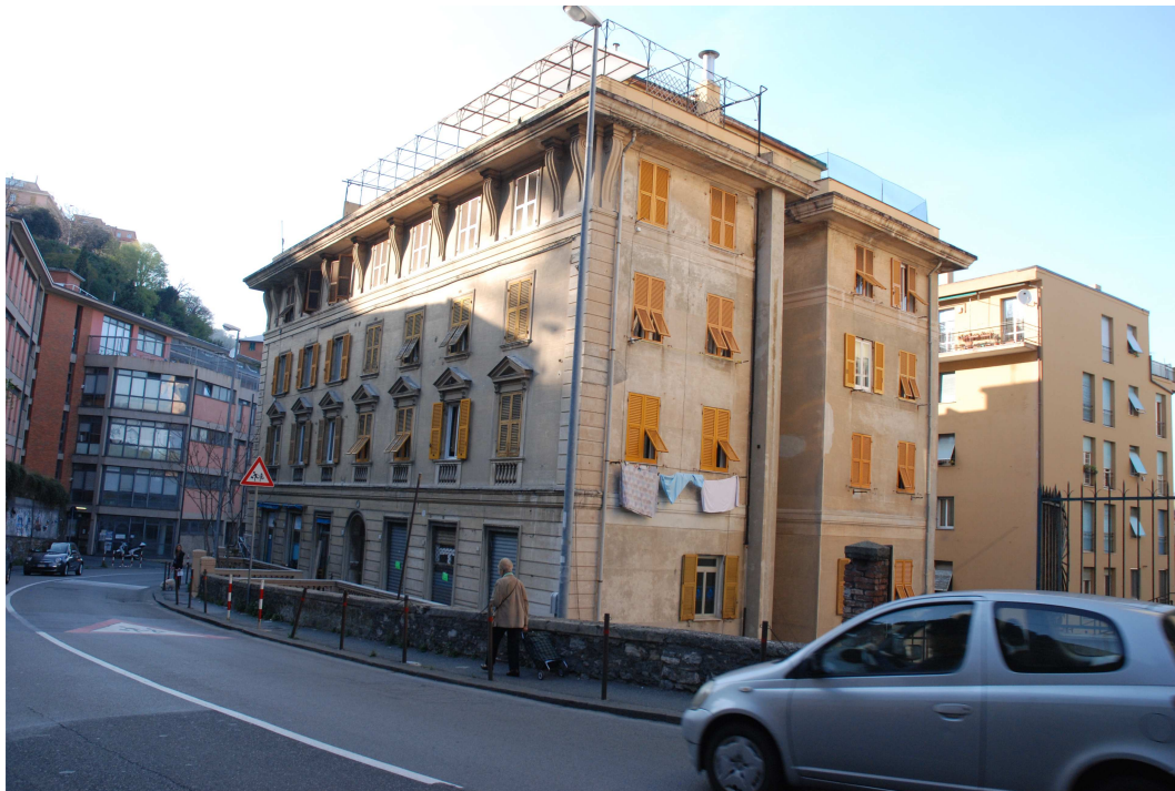
Foto n. 1 – Edificio civico 36 via L.Montaldo,Genova
