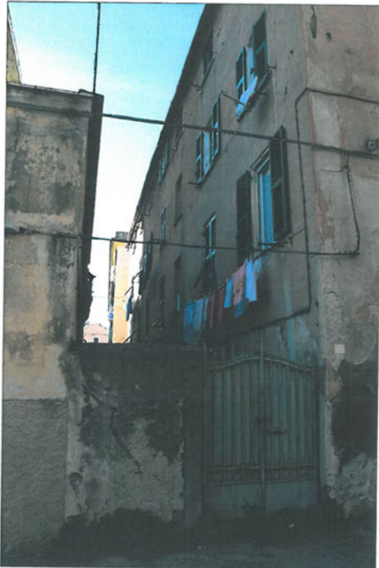
Foto n° 3 - Facciata laterale Civ. 22.
