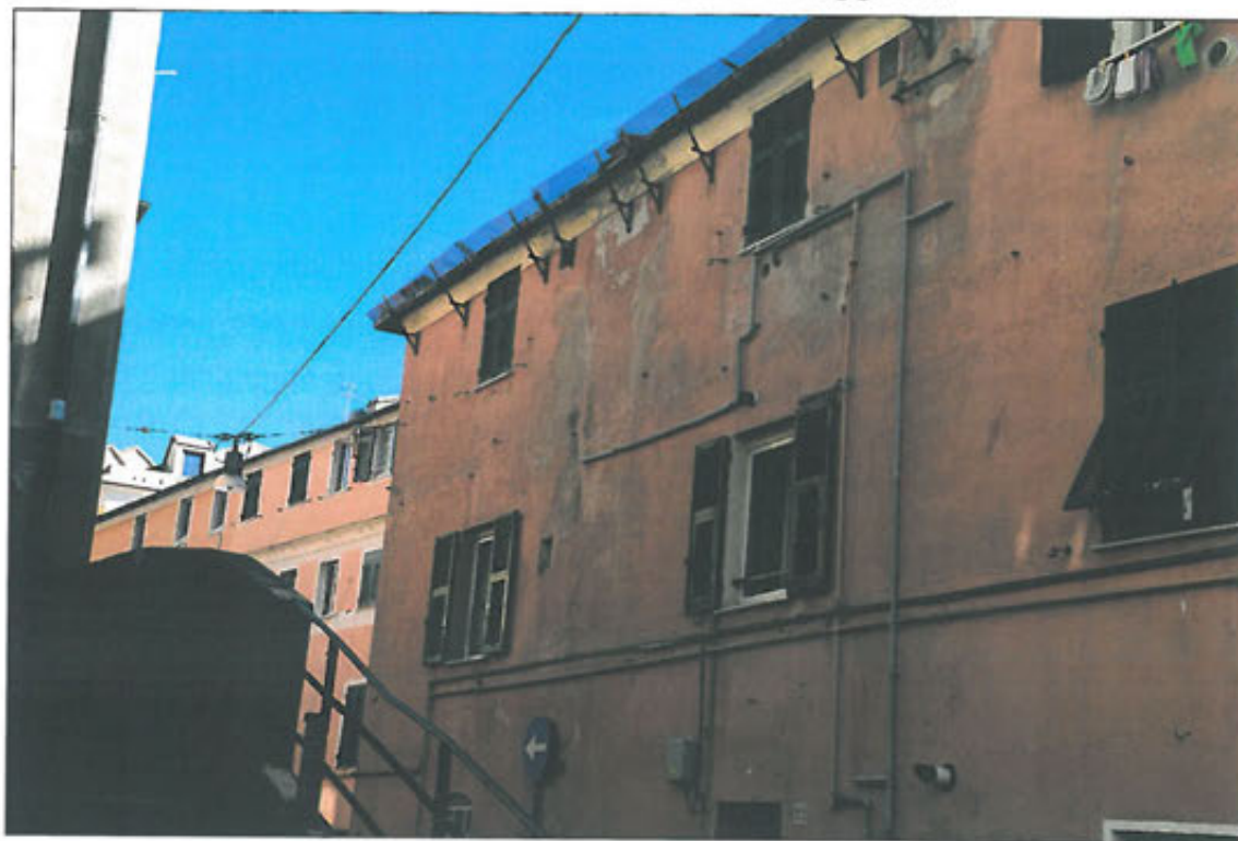
Foto n° 5 - Particolare finestre immobile in oggetto.
