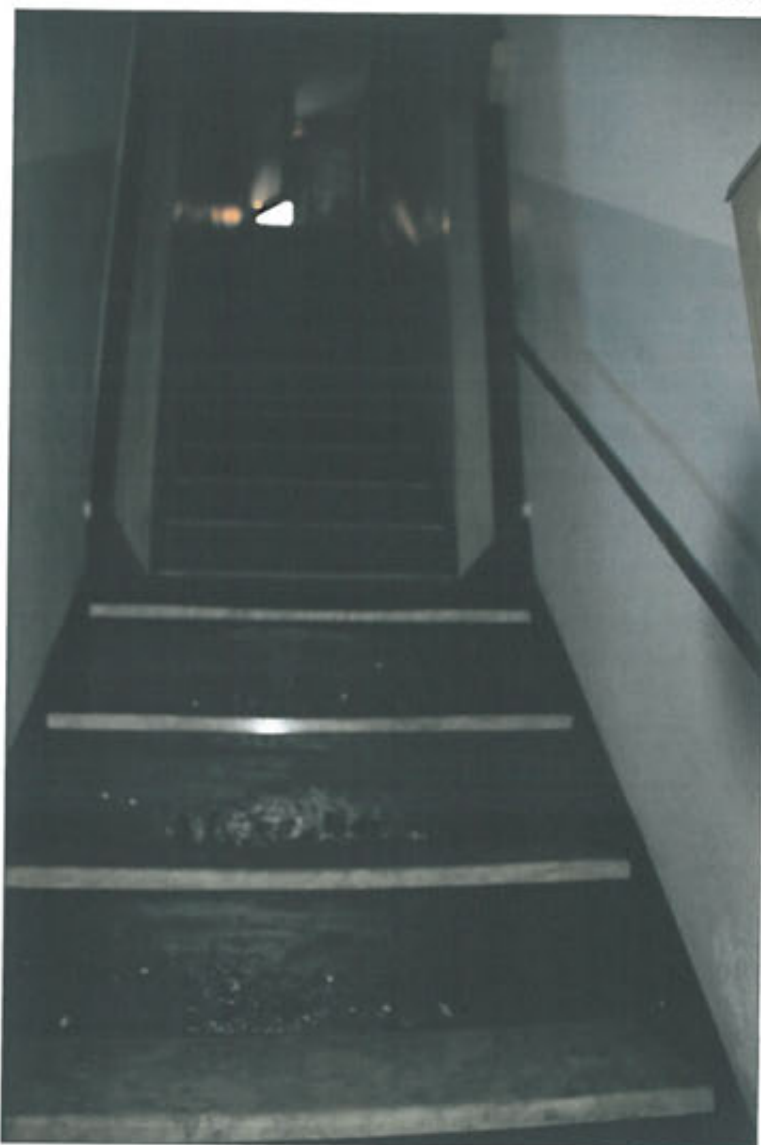
Foto n° 7 - Scala interna d'accesso immobile int. 1.
