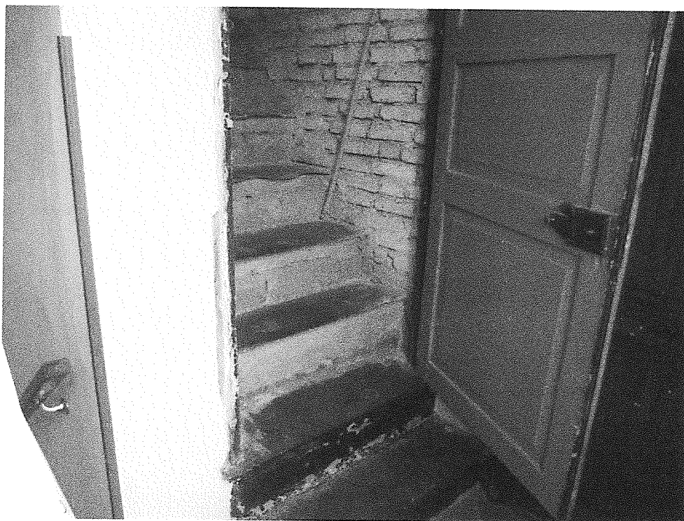
Foto n° 12 – Vista interna accesso al sottotetto dal vano scale
