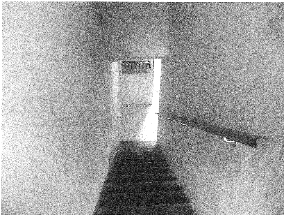
Foto n° 4 – Vista vano scale di accesso.
