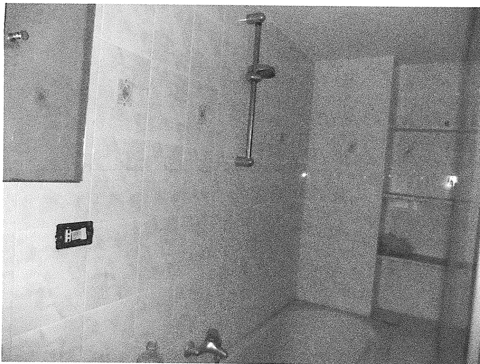
Foto n° 11 – Vista interna– Bagno
