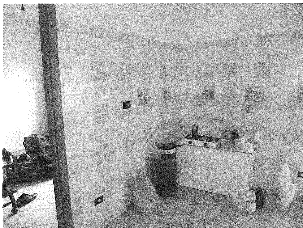
Foto n° 8 – Vista interna – Cucina
