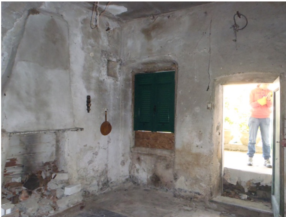
FOTO 14 - Interno cantina sub 1
