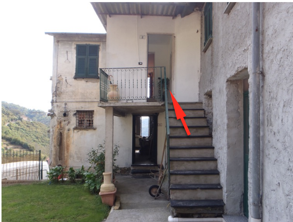
FOTO 19 - Accesso al sub 4 al p. 2 e accesso sub 1
