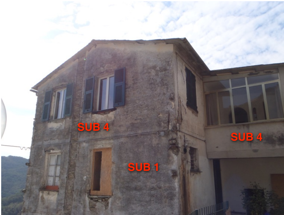
FOTO 3 - Particolare prospetto nord est
