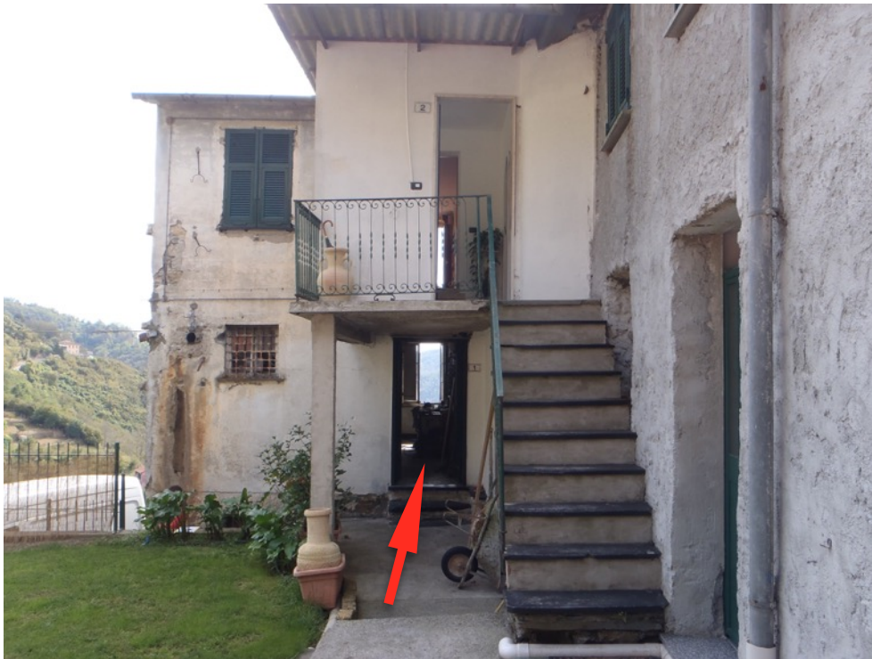
FOTO 9 - Ingresso appartamento sub 1 e scala verso il sub 4
