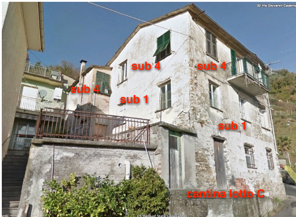
FOTO 8 - Prospetto su Via Aveggio
