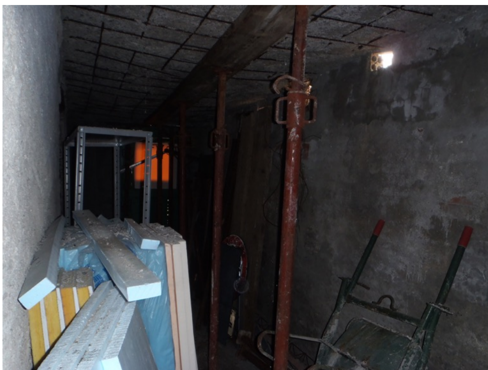
FOTO 30 - Porzione controterra su distacco sud ovest
