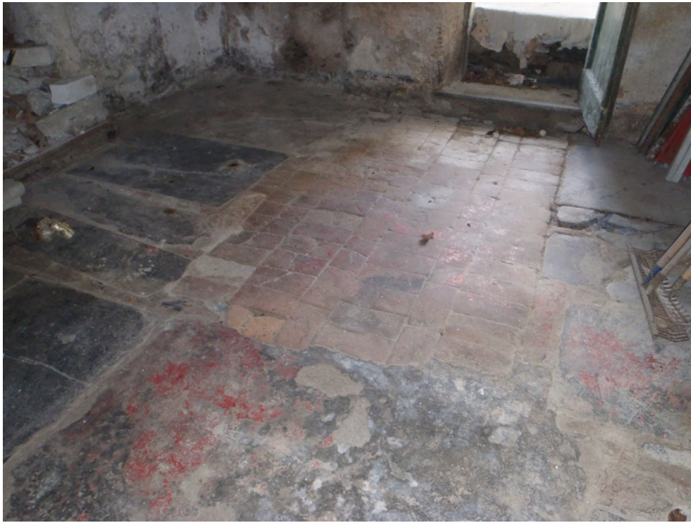
FOTO 13 - Interno cantina sub 1
