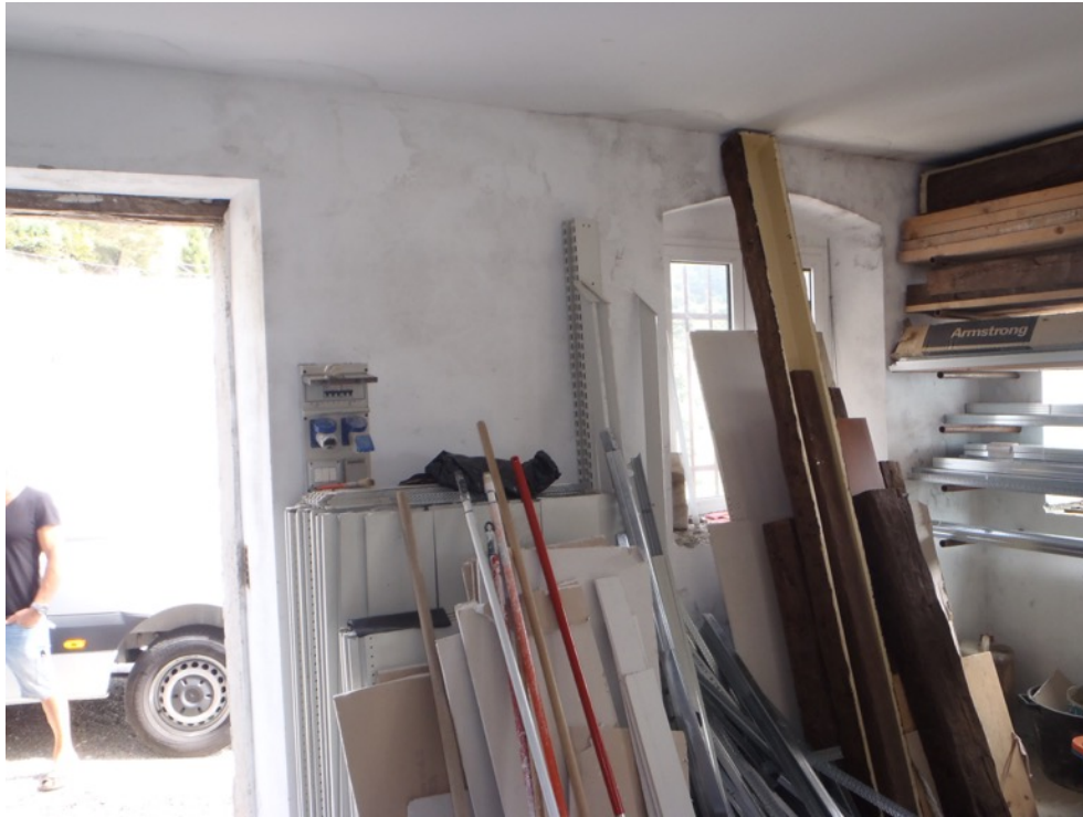
27 - Accesso dalla corte comune
