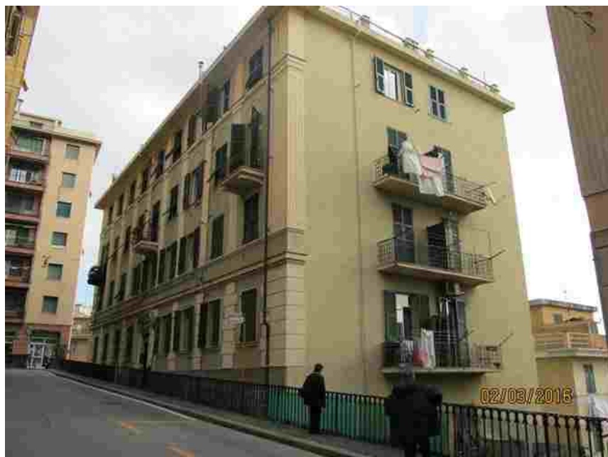
fot. 2 - facciata sud
