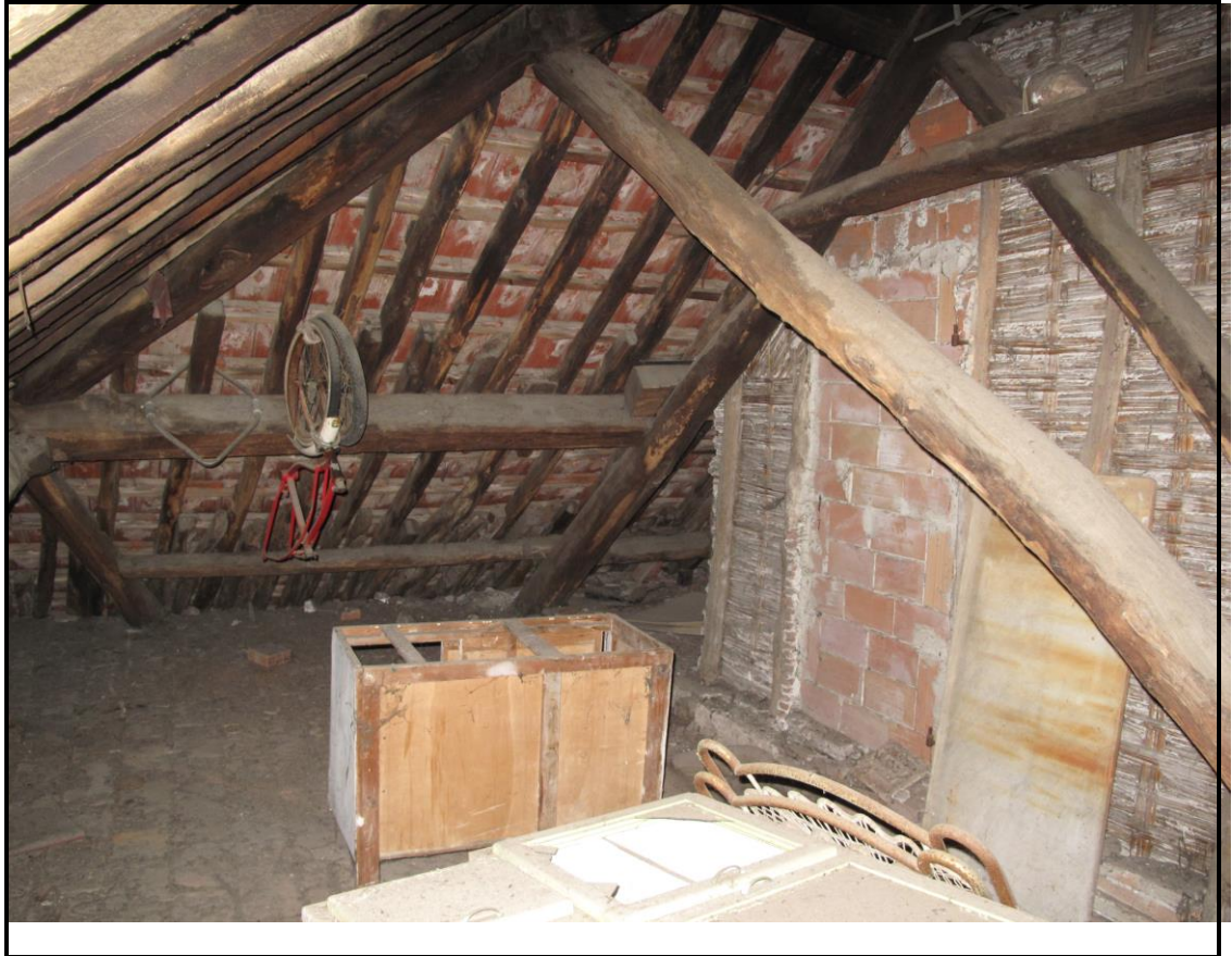
Foto 11 – porzioni sottofalda ad uso cantina
