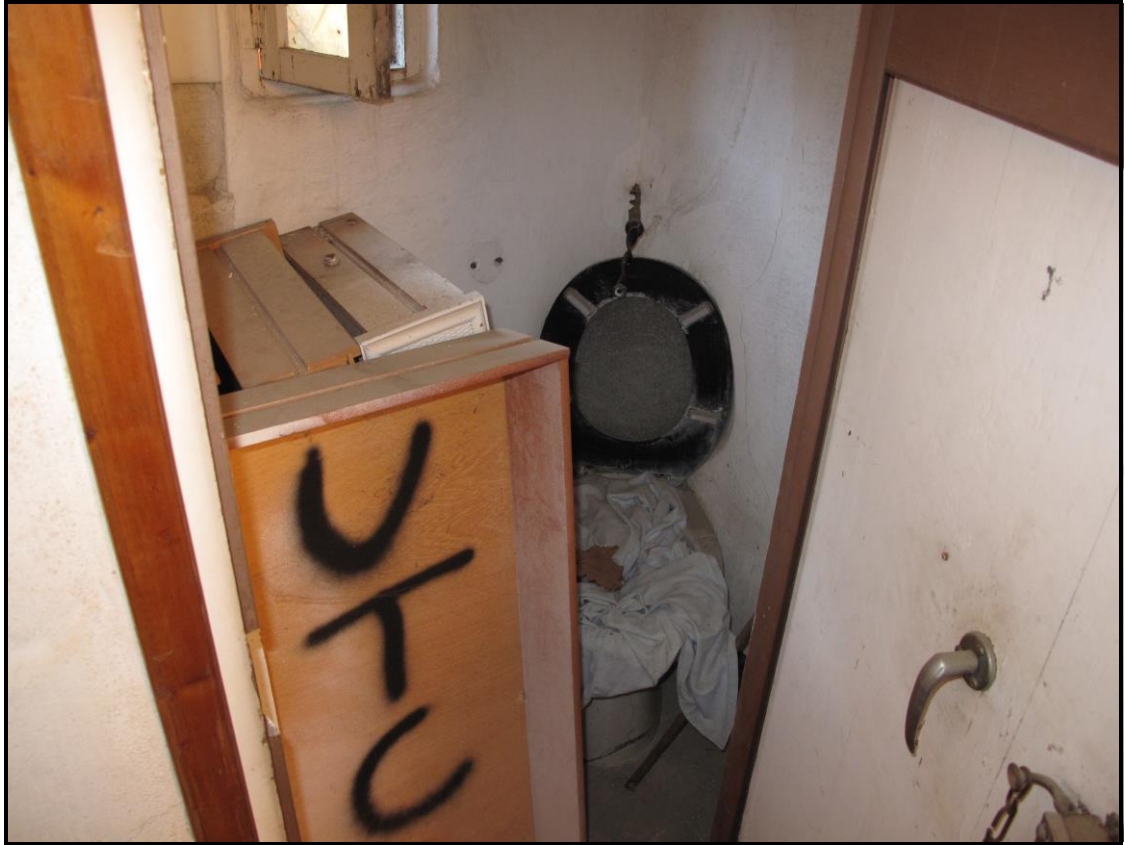
Foto 7 – w.c. posizionato nel vano scale
