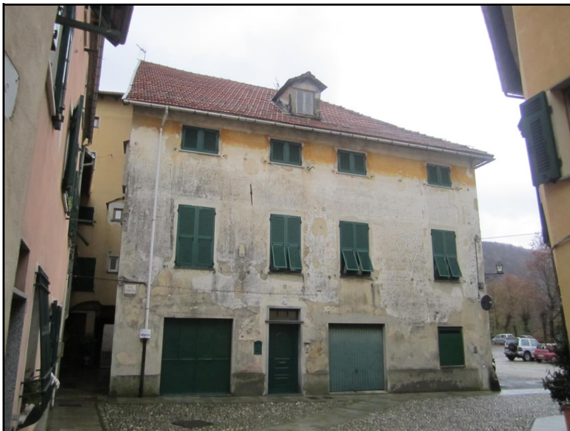
Foto 4 – prospetto su Via Podestà
