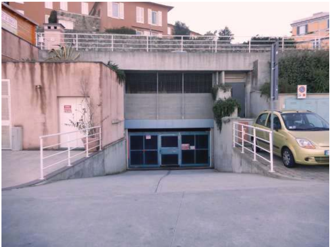
FOTOGRAFIA n. 3 - Rampa di accesso al piano S2 dei box.
