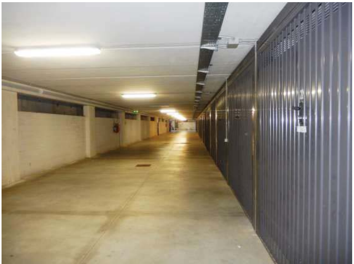
FOTOGRAFIA n. 4 - Corsia condominiale del piano S2.
