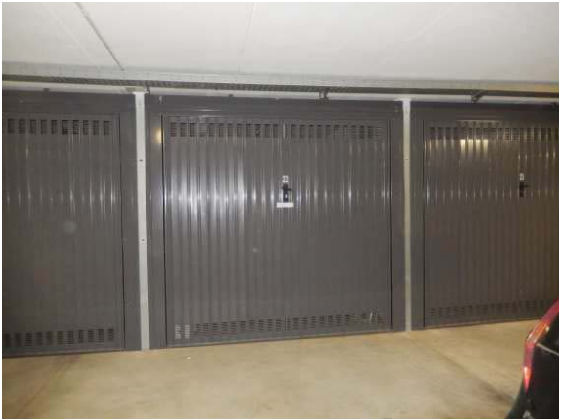
FOTOGRAFIA n. 5 - Serranda del box n. 22 (Part. 2739 sub 20).
