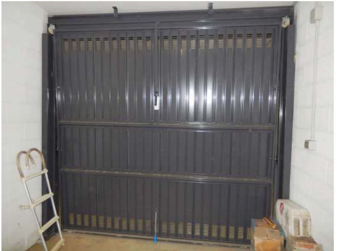
FOTOGRAFIA n. 9 - Lato interno della serranda del box n. 22.
