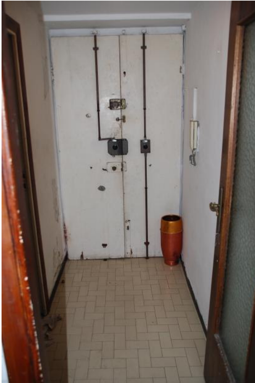
Foto 1 – Ingresso I – verso porta di accesso
