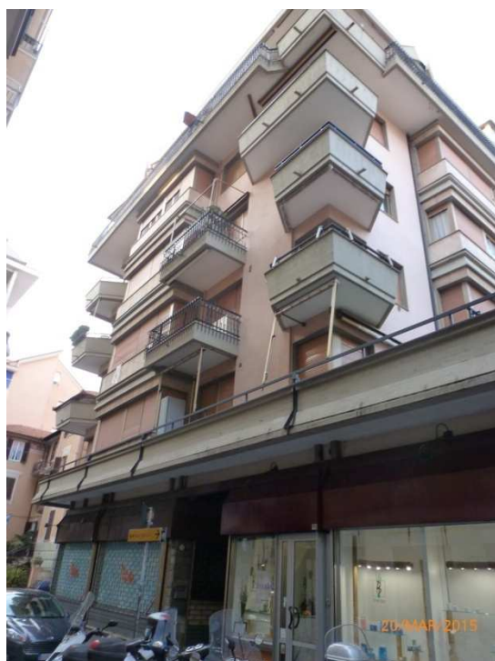
Prospetto sud sulla via Belvedere
