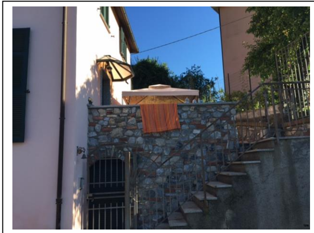
Foto n. 2 : scala accesso piano terra
