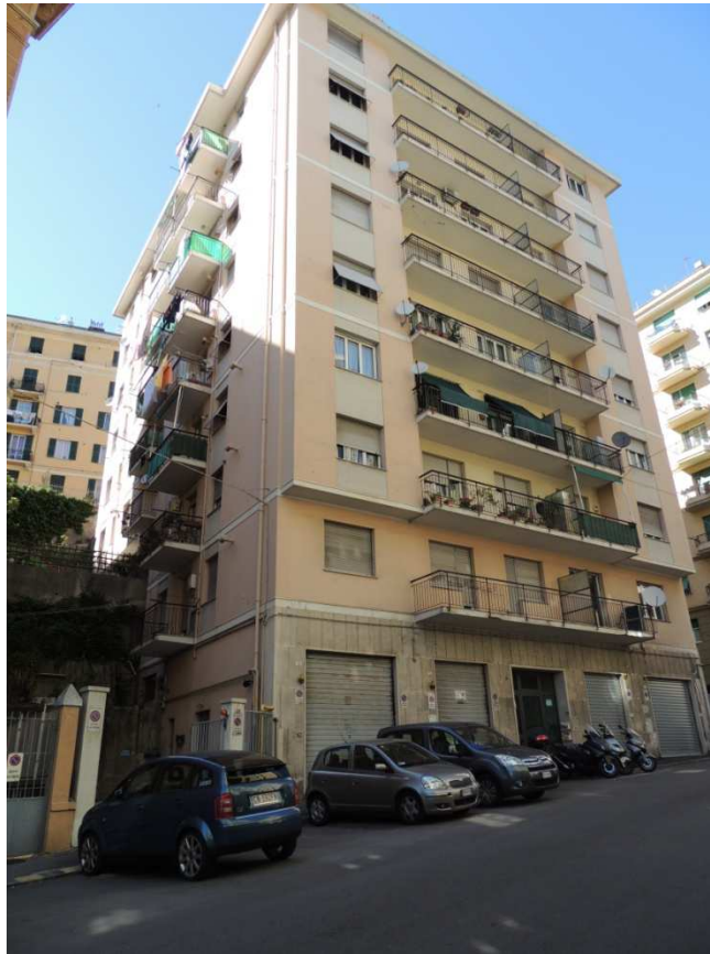
Foto n°1 – Edificio in Corso Martinetti civ 66 – Genova
