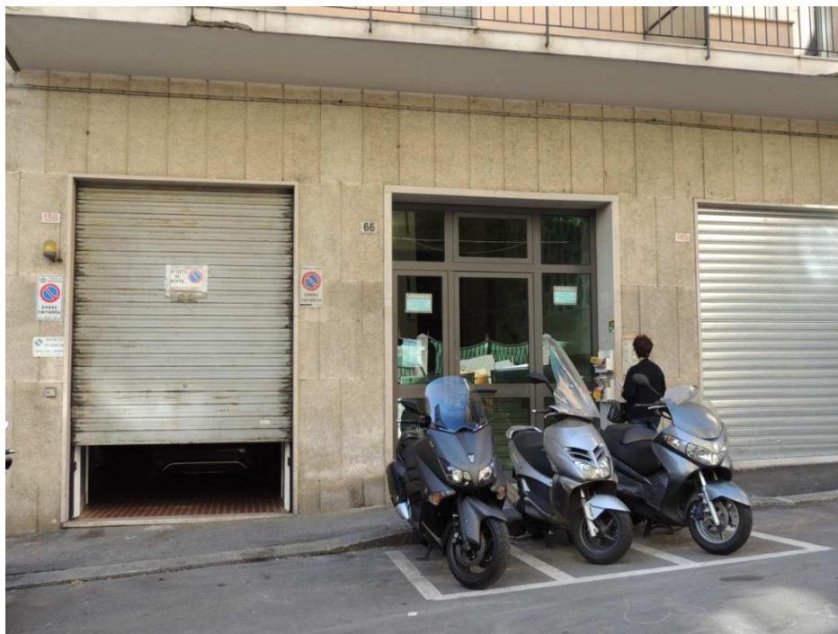
Foto n°2 – Portone esterno civ 66 - Genova
