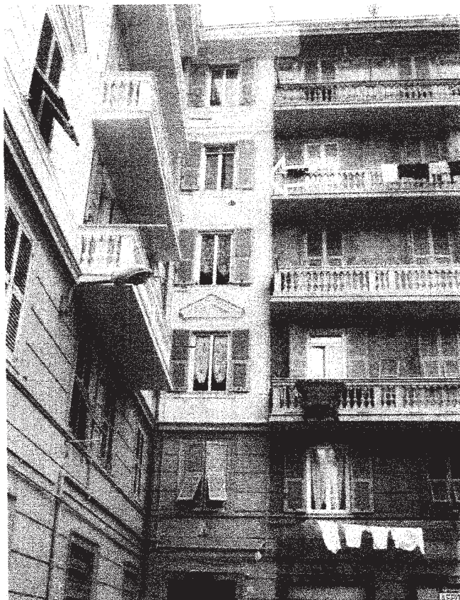
Vista lato nord edificio
