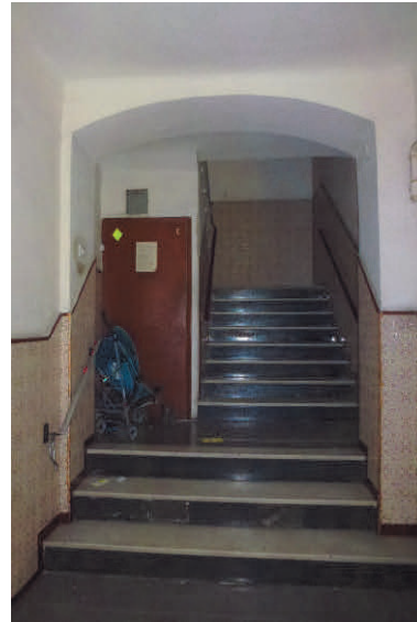
Foto 2 Vista dell'atrio di accesso al caseggiato
