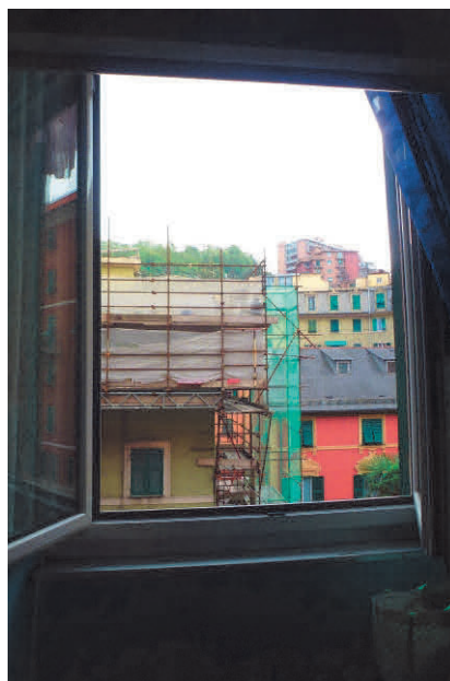
Foto 11 Vista su via Fillak
