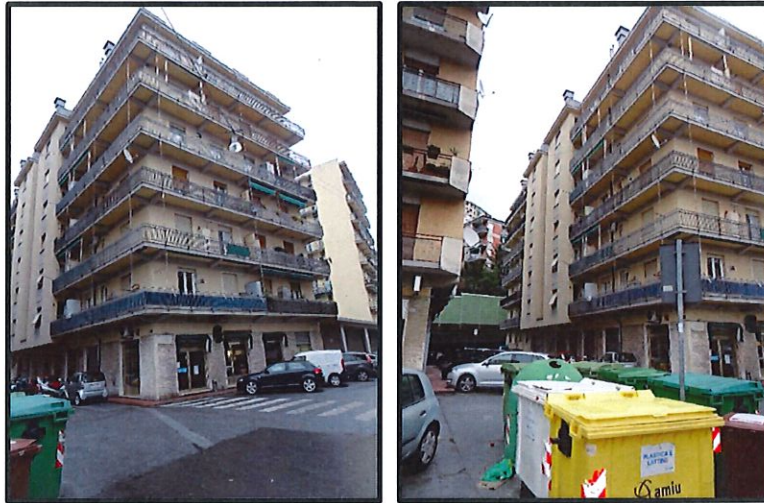
Foto 1-2: Viste del fabbricato civ. 193 di Via San Remo
