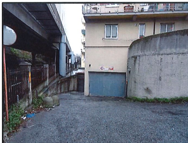
Foto 4: Accesso all'autorimessa civ. 195 A
