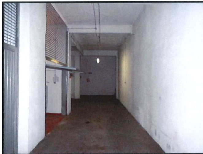
Foto 6: Corsia di manovra
