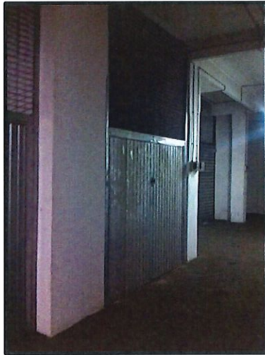
Foto 5: Vista dell'accesso al box n. 7
