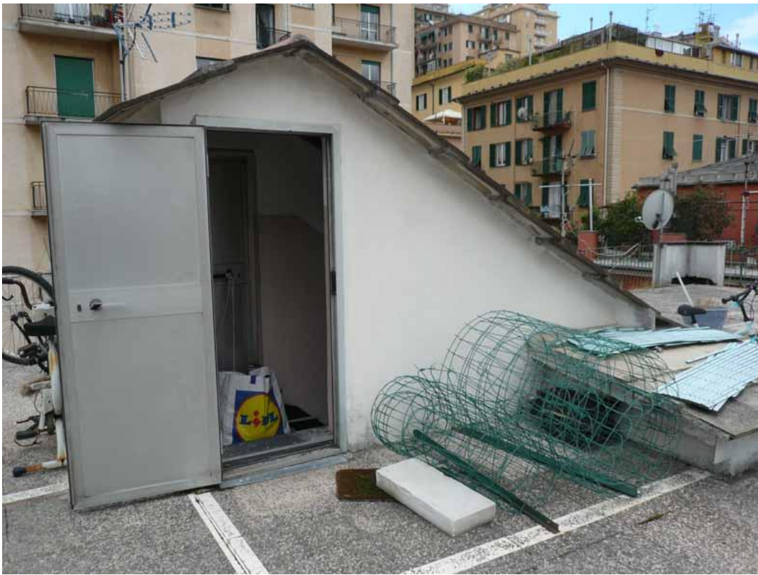
21) Porta accesso terrazzo in copertura
