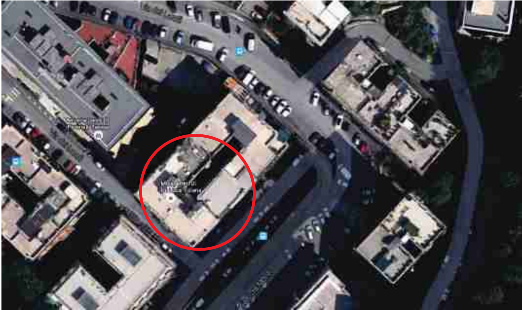
Figura 5 – Vista aerea della zona con indicazione fabbricato
