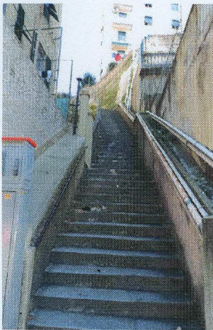
Scala esterna di accesso
