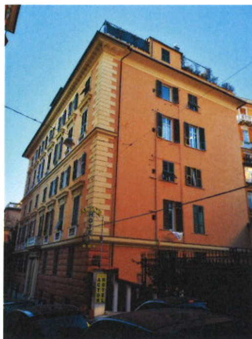
FOTO 1 - prospetto nord da via Goito (ingresso hotel)
