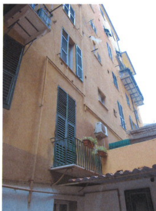
FOTO 3 - prospetto retro su distacco di proprietà
