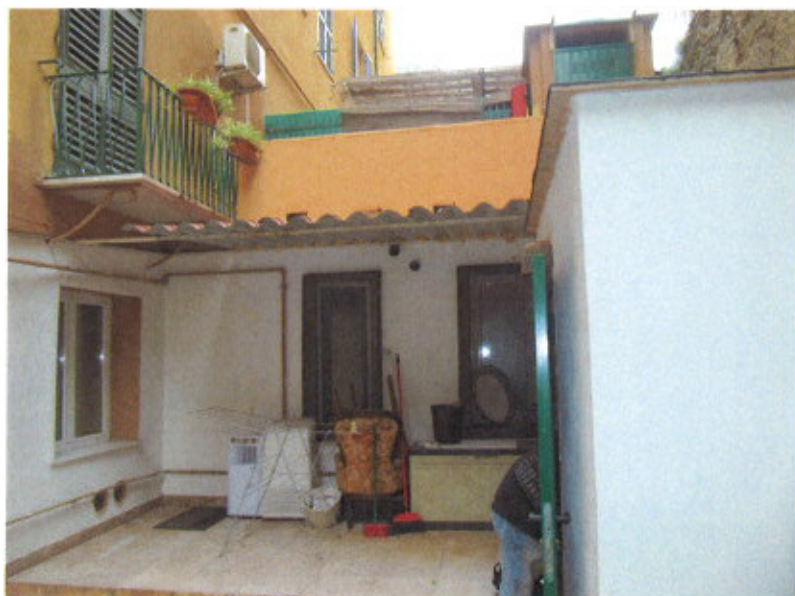
FOTO 7 - distacco di proprietà
