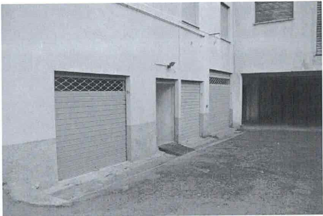
FOTO 20—cortile di accesso al locale cantine
