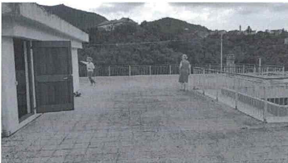
FOTO 4— lastrico solare ad uso esclusivo
