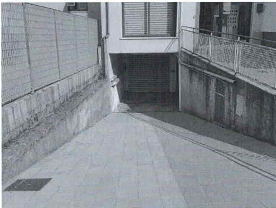
FOTO 1—rampa di accesso al piano seminterrato
