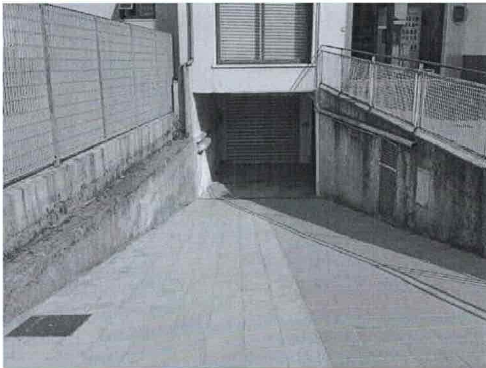
FOTO 1—rampa di accesso al piano seminterrato
