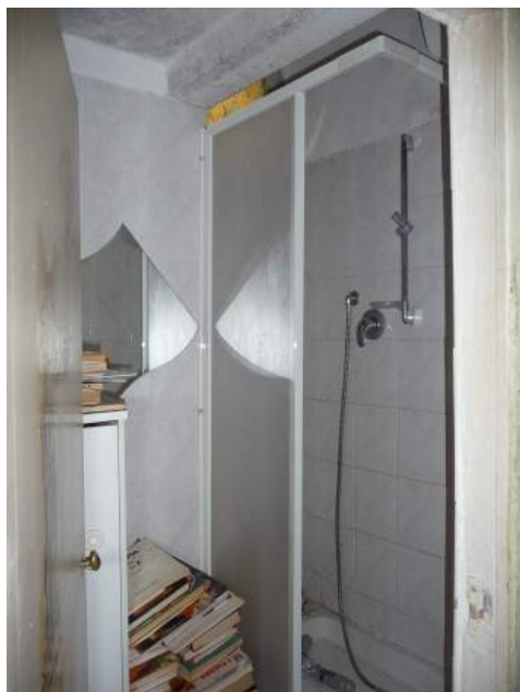
Foto 14. Vano doccia con finestrino su Vico Boccanegra.
