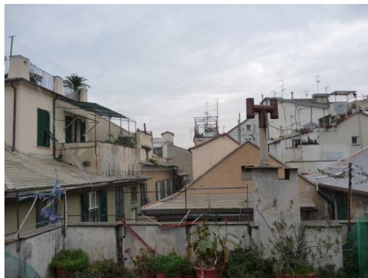
Foto 16. Terrazzo – parapetto su vico Boccanegra
