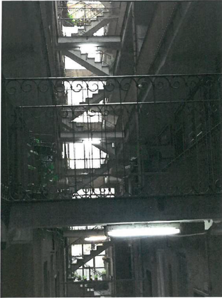
Foto 7: VANO SCALE CONDOMINIALE.
