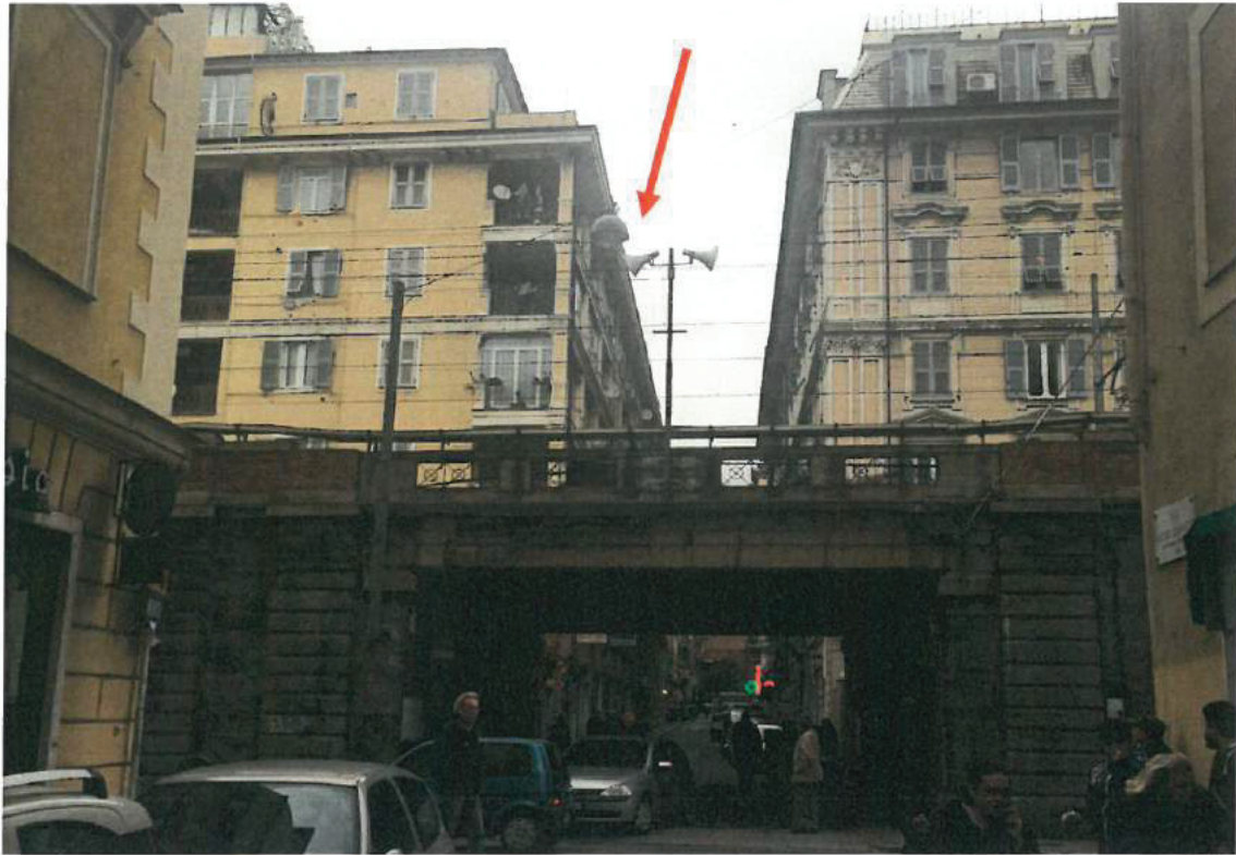
Foto 1: IMMOBILE SITO IN COMUNE DI GENOVA, VIA GIACOMO GIOVANETTI CIV. 6 INT.38 – PROSPETTO SUD-EST.
