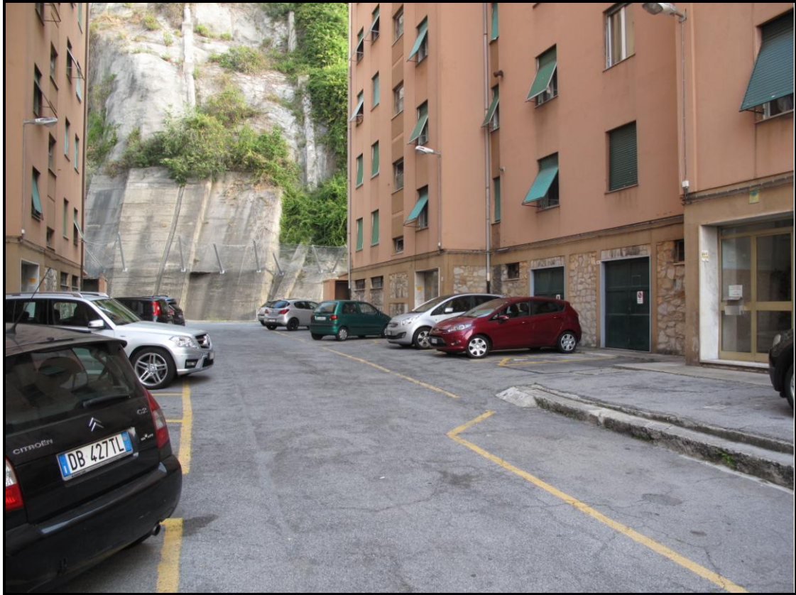
Foto 3 – distacco di accesso condominiale
