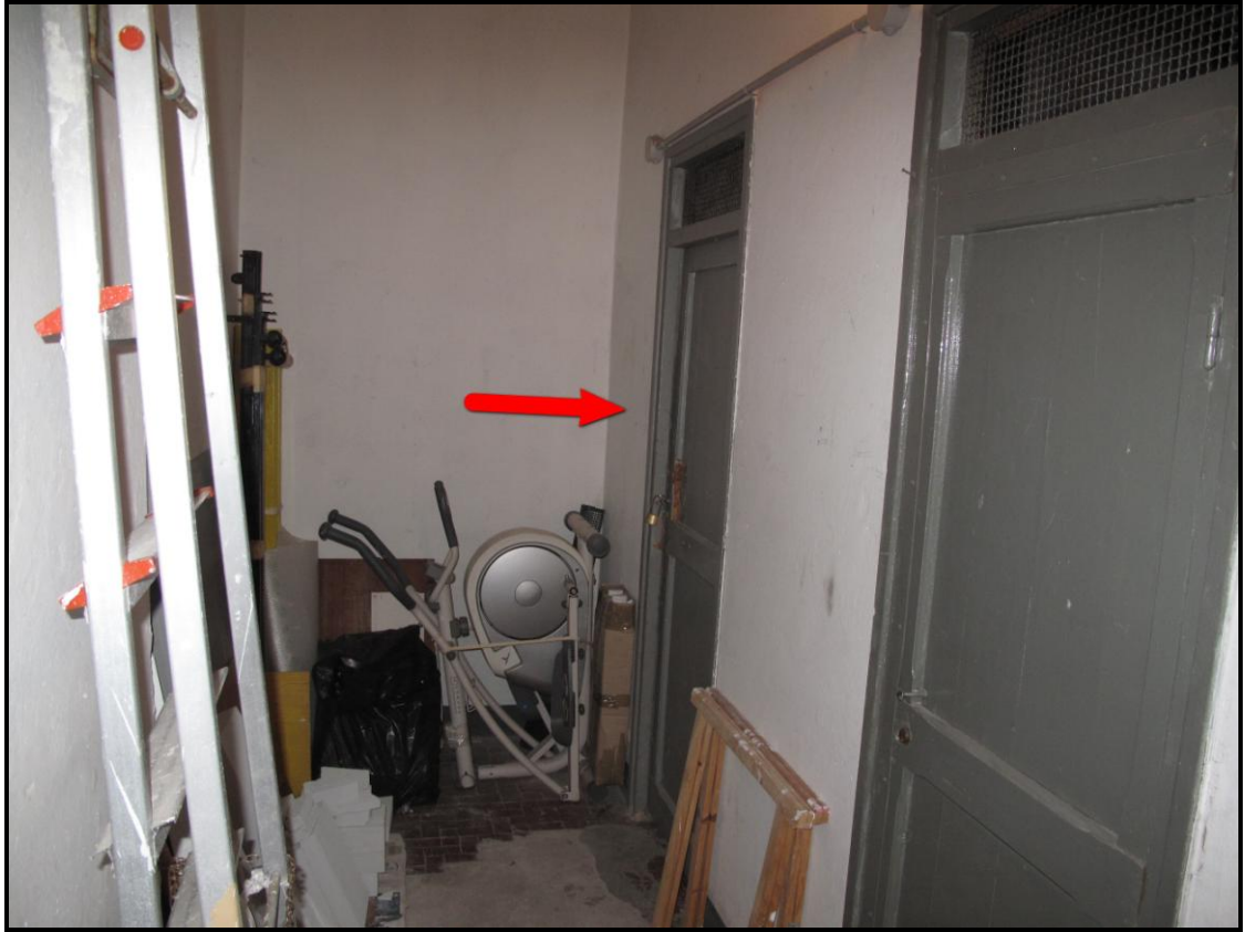
Foto 13 – cantina al piano terra
