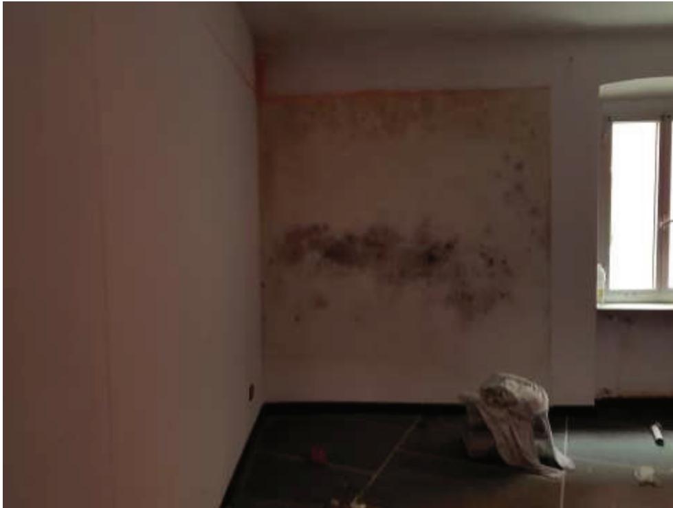
FOTO 17—PARTICOLARE CONDENZA CAMERA FOTO 16
