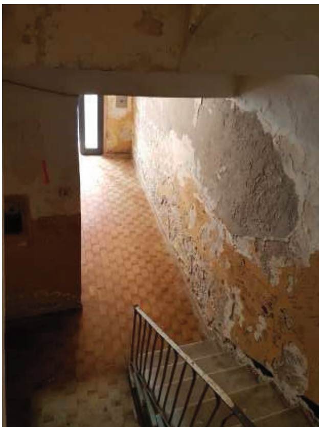
FOTO 5—PARTICOLARE MANUTENZIONE ATRIO
