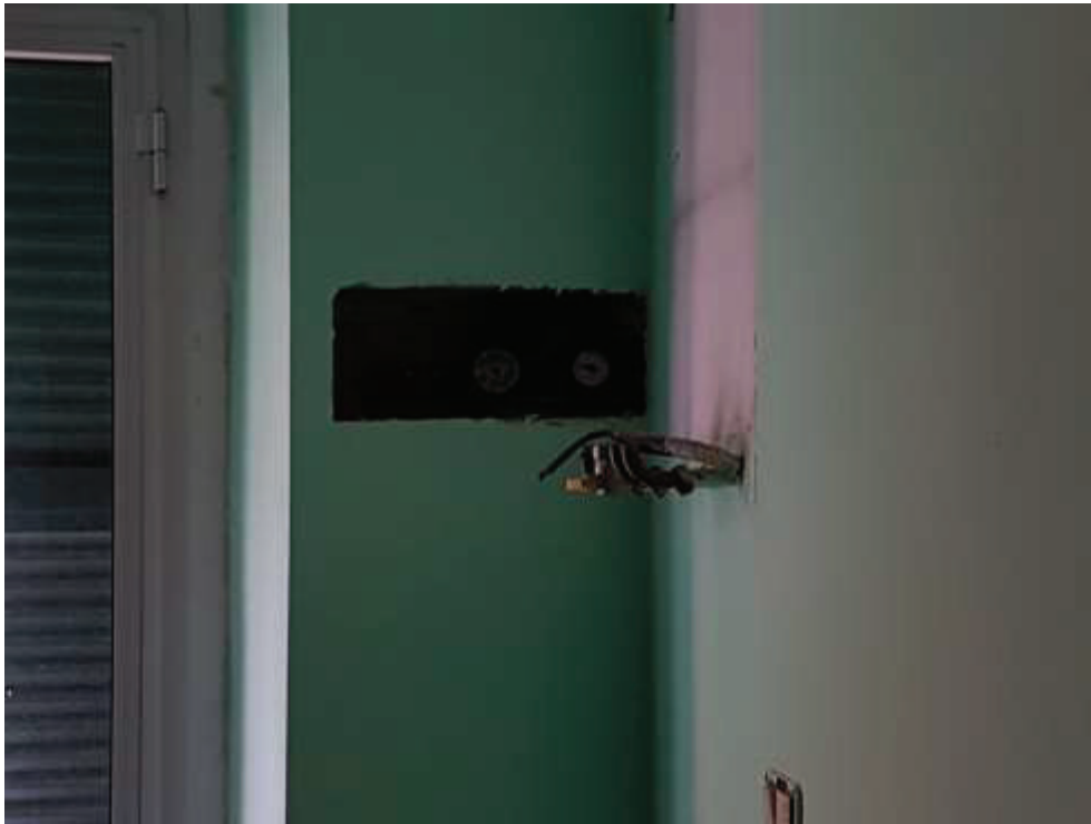
FOTO 21—PARTICOLARE PUNTO DI INSTALLAZIONE CALDAIA
