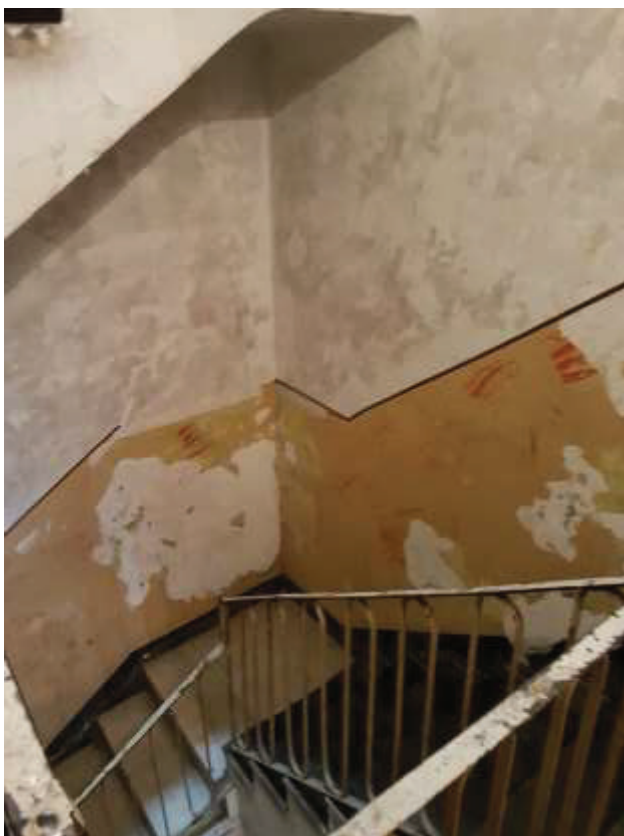
FOTO 6—PARTICOLARE VANO SCALA
