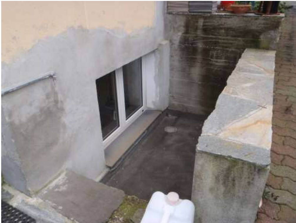
FOTO 25— PROSPETTO OVEST PIANO 2SS
