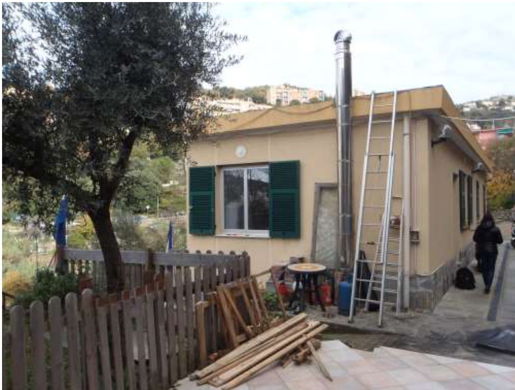
FOTO 3—PROSPETTO NORD PIANO 1SS
