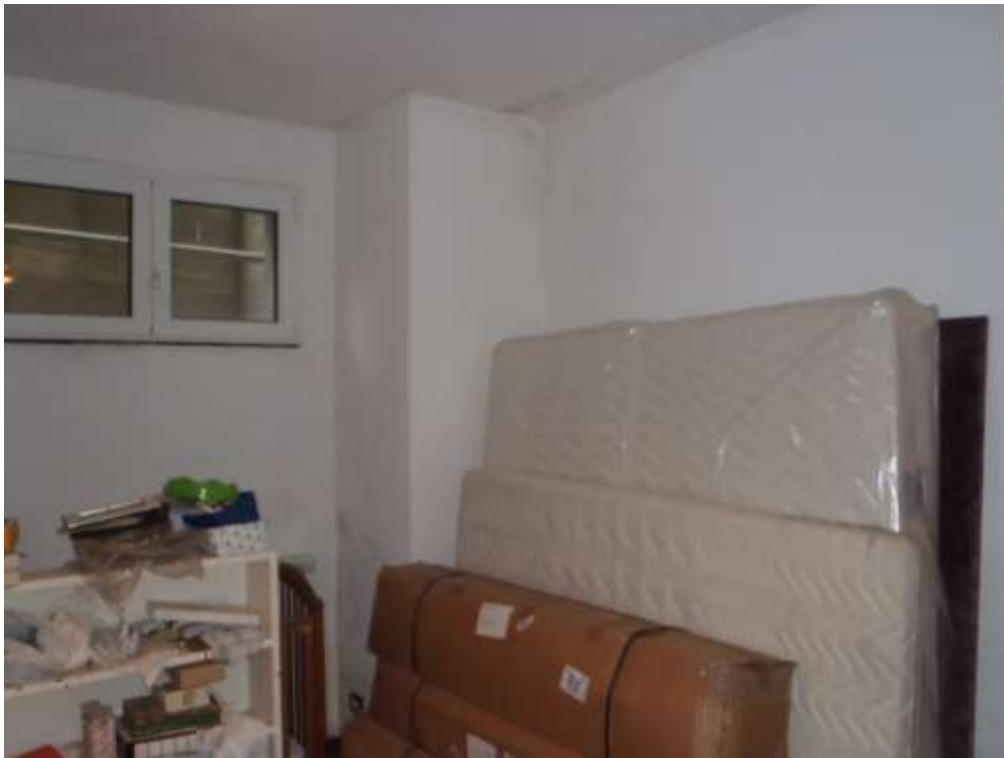
FOTO 39— LOCALE 4 SU INTERCAPEDINE VIALE PRIVATO
