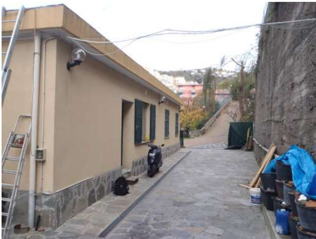
FOTO 2— PROSPETTO SUD E RELATIVO ACCESSO AL PIANO 1SS
