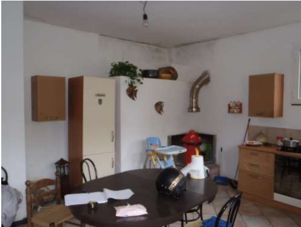
FOTO 35— CONDENSA NELL'ANGOLO COTTURA
