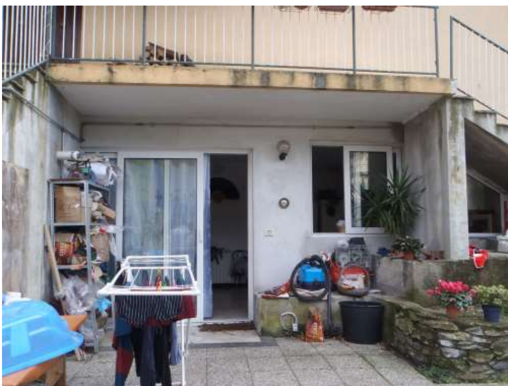
FOTO 32—PARTICOLARE INGRESSO PIANO 2SS
