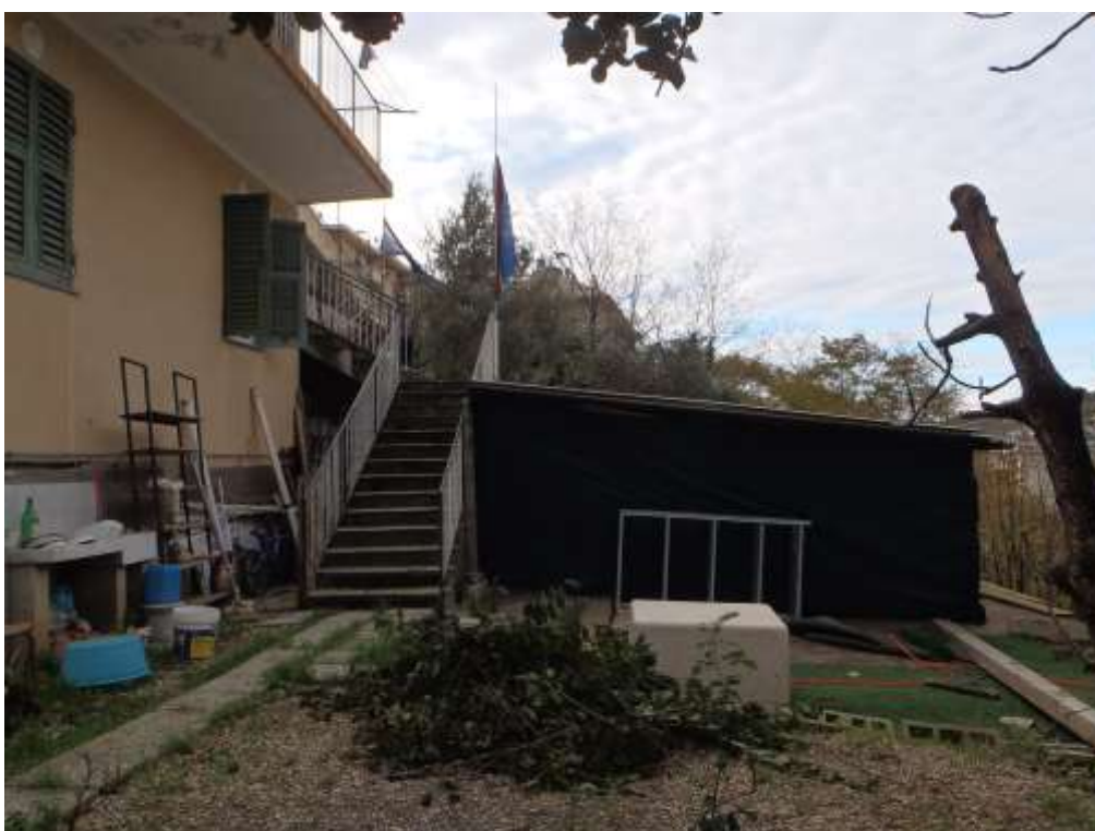
FOTO 28—CORTE AL PIANO 2SS E TETTOIA ABUSIVA
