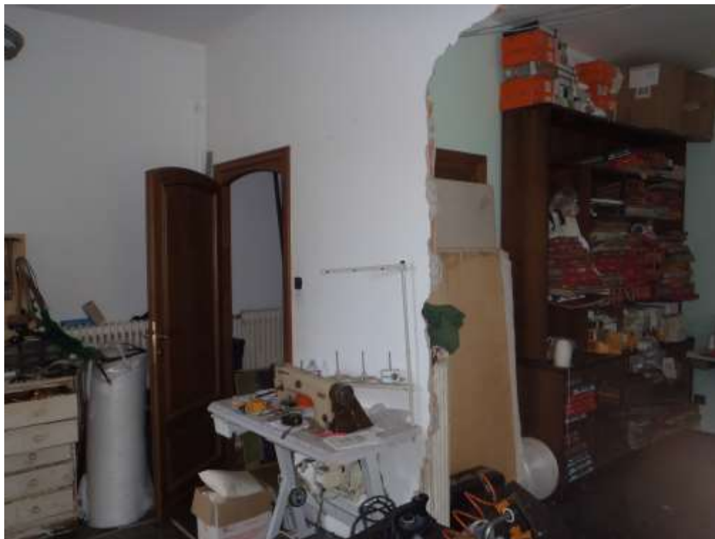
FOTO 8—DEMOLIZIONE INCOMPLETA VERSO IL LOCALE ATIGUO AL LABORATORIO
