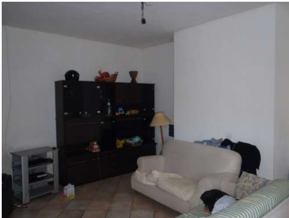
FOTO 36—ALTRA VISTA LOCALE CENTRALE PIANO 2SS
