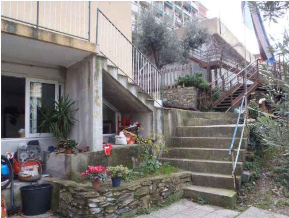
FOTO 33— ALTRA VISUALE INGRESSO PIANO 2SS
