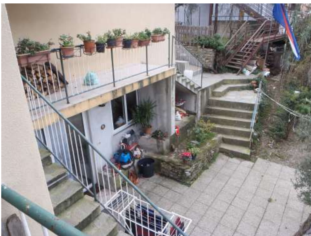
FOTO 22—PROSPETTO NORD PIANO 2SS
