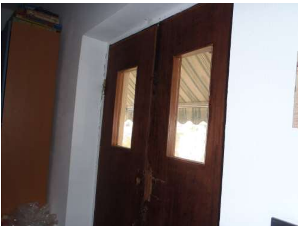
FOTO 10— PORTA DI INGRESSO SUL PROSPETTO NORD
