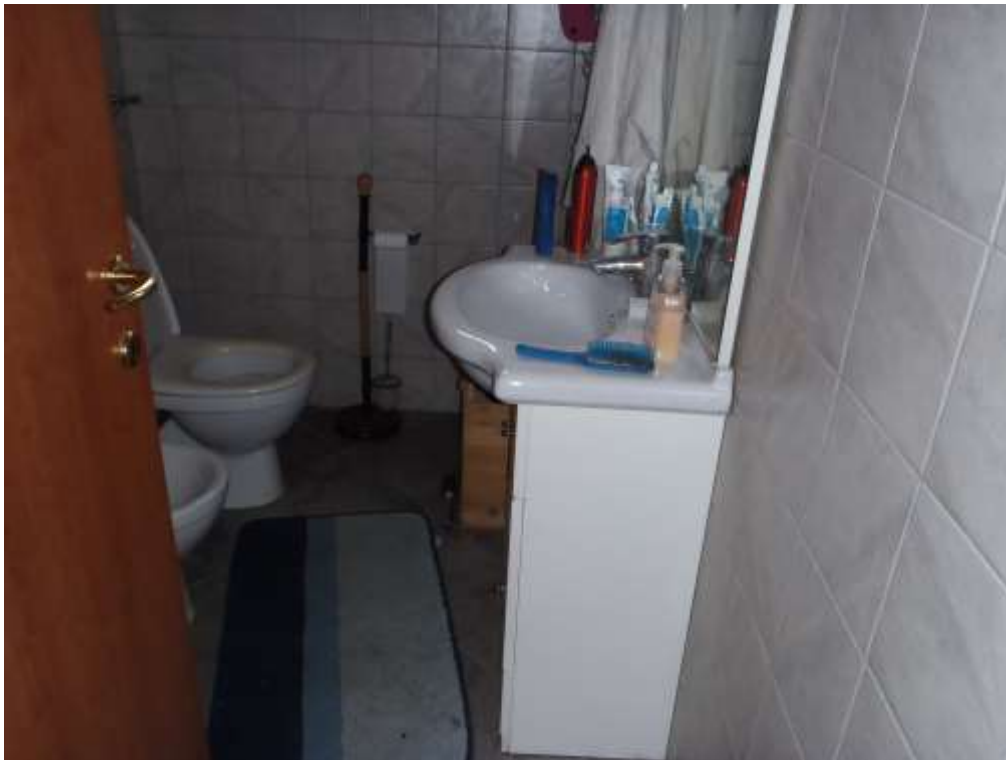
FOTO 41— WC PIANO 2SS
