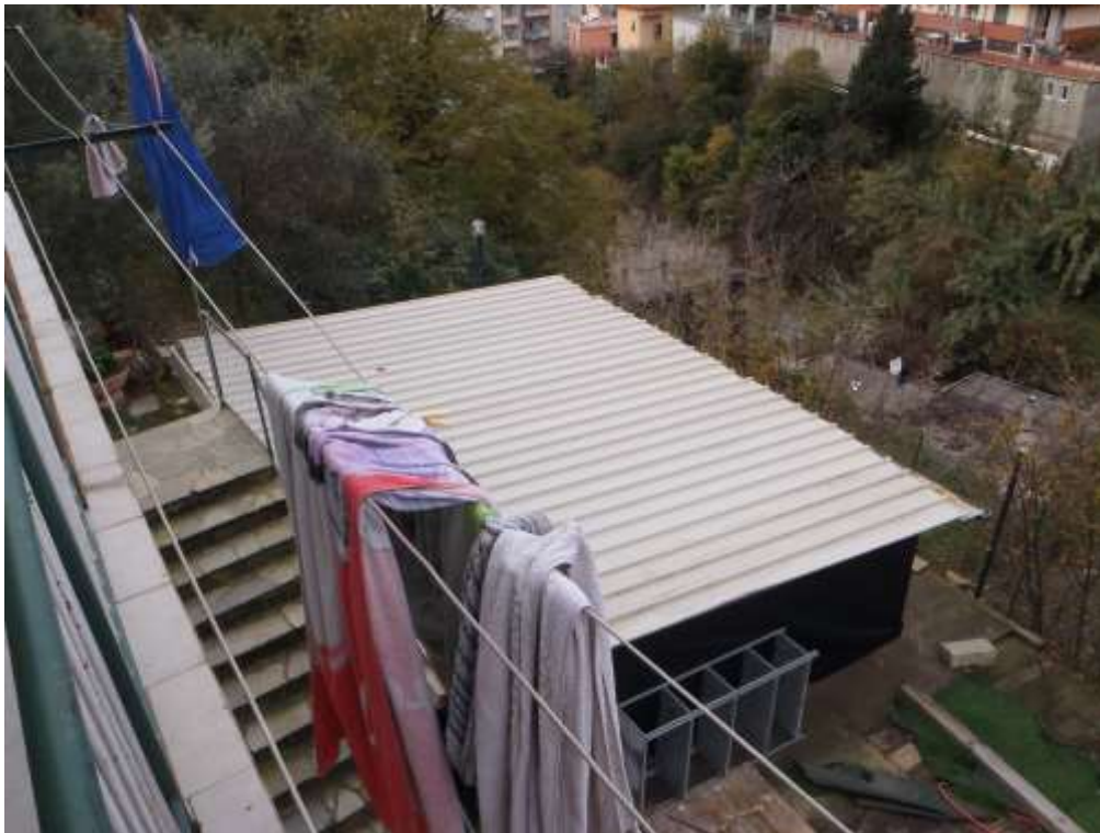
FOTO 5—TETTOIA ABUSIVA DA DEMOLIRE
