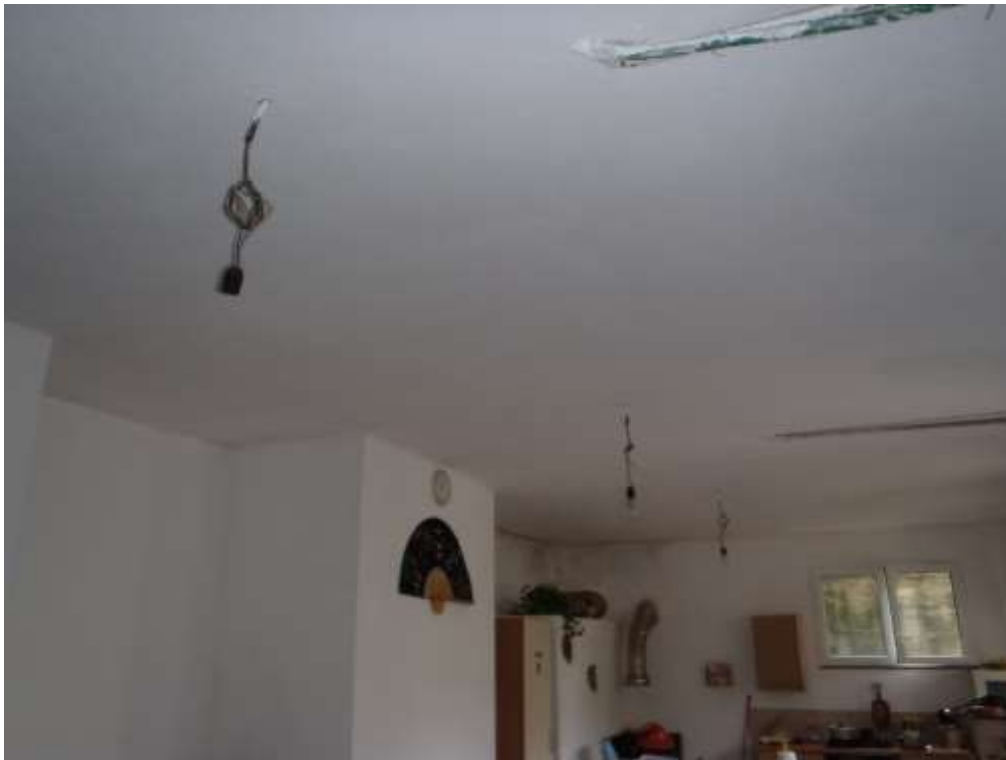
FOTO 37— PARTICOLARE SOFFITTO LOCALE CENTRALE PIANO 2SS
